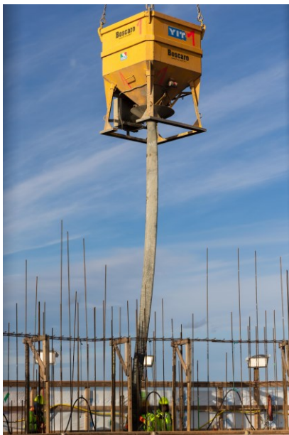
Kuva 22. Liukuvalussa käytettiin betoninnostoastiaa, jonka tilavuus oli 4 kuutiometriä (Kuva Juho Humalainen).
