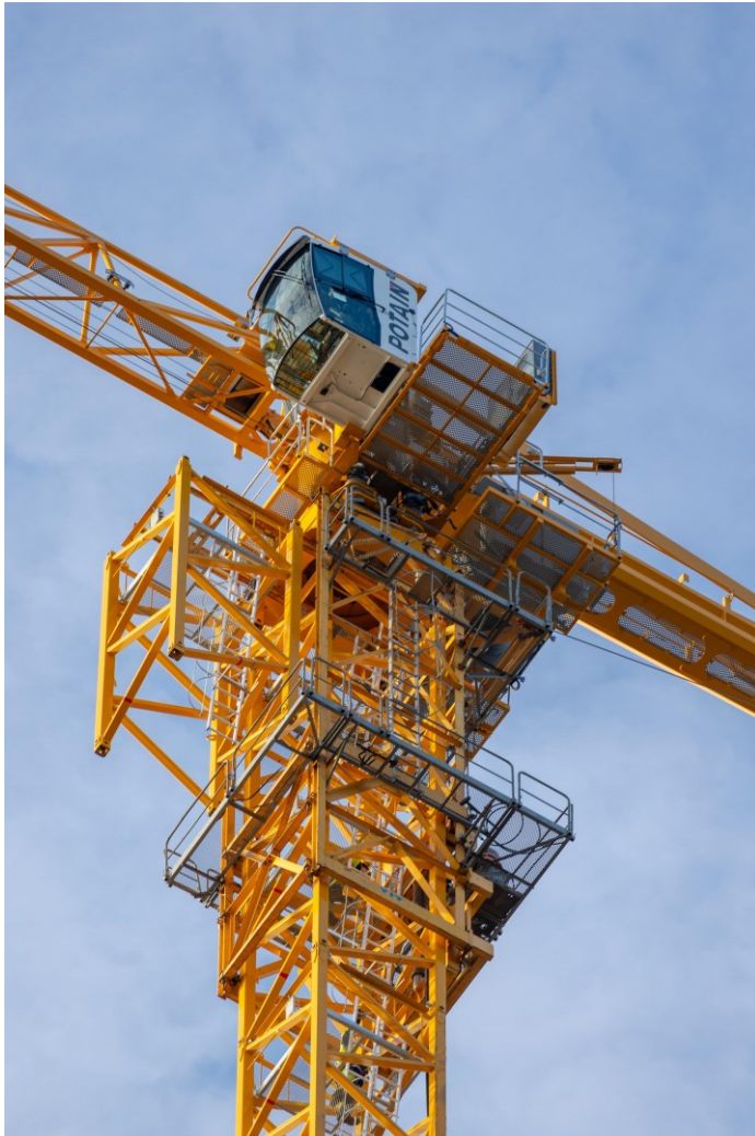
Kuva 20. Nosturin korotus tunkkaamalla käynnissä case-kohteessa (Kuva Juho Humalainen).
