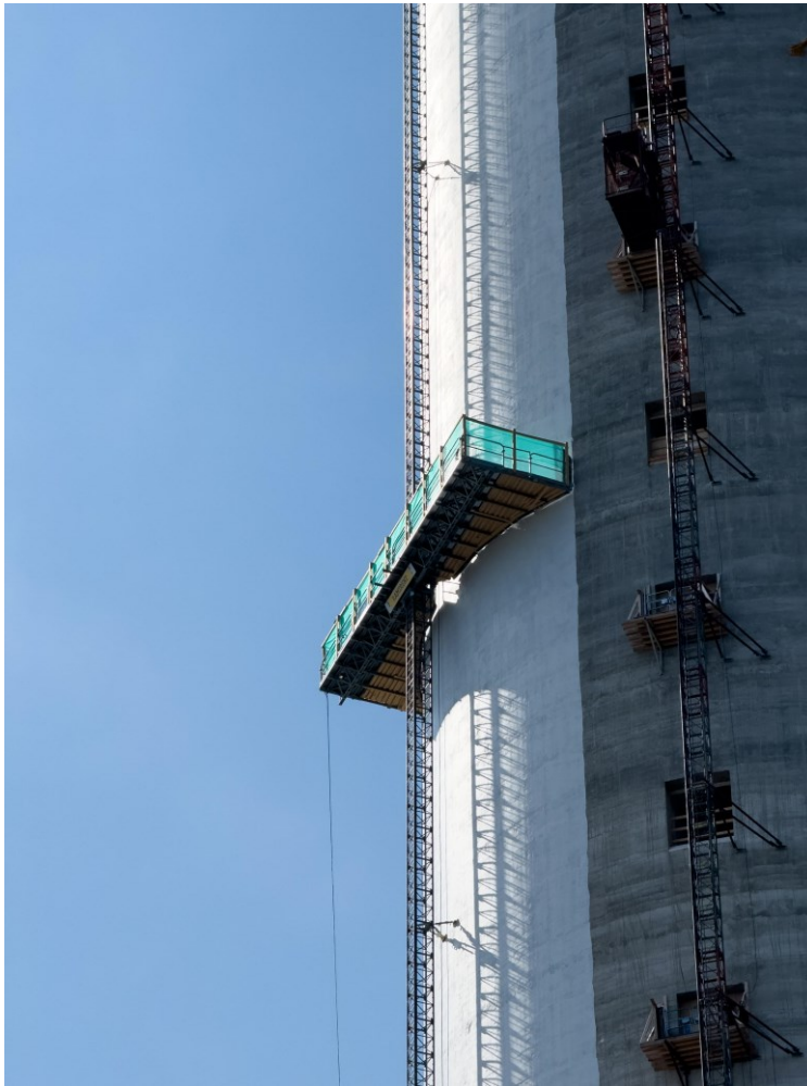
Kuva 21. Yleiskuva Case-kohteen julkisivulle asennetusta mastolavasta (Kuva Juho Humalainen).
