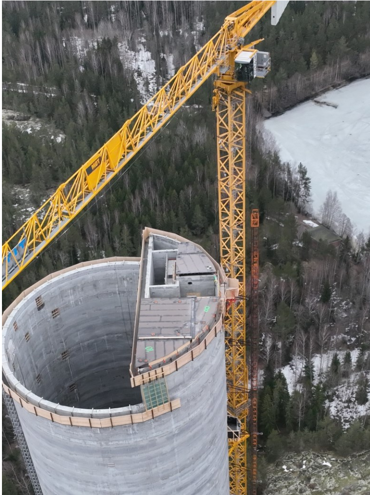
Kuva 15. Tornin huipulle rakennettiin telineet, joilta päästiin ohjaamaan tornin sisälle nostettavia kappaleita kuluun (Kuva Tomi Rolig).
