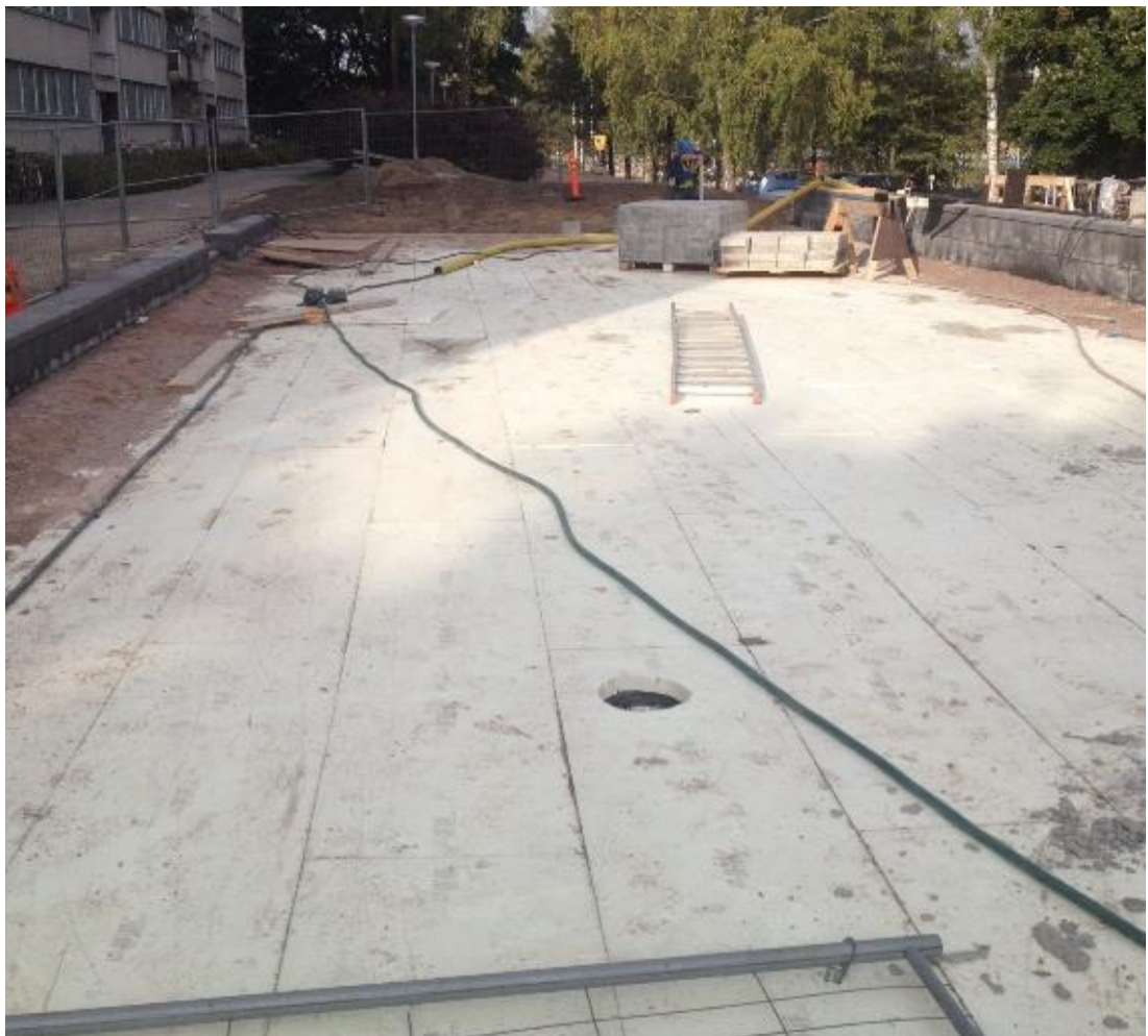
Kuva 8. Vedeneriste suojattu Finnfoam-eristyslevyillä [6 .]
