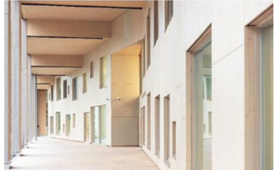
Kuva 42. Päiväkoti Martta Wendelin pääsisäänkäynti.
