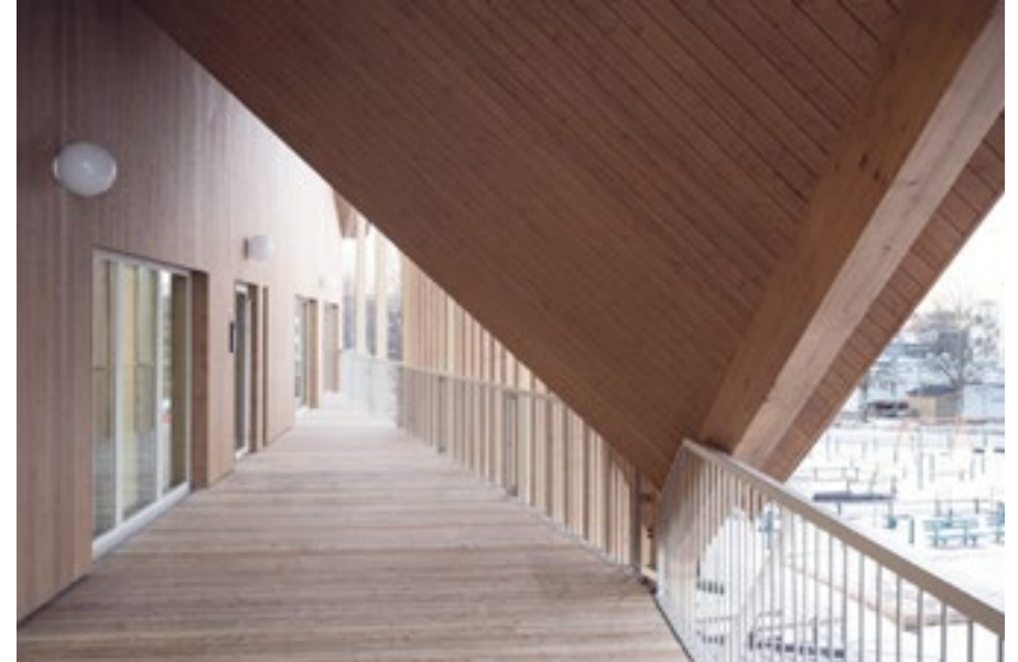
Kuva 41. Katettu ja rimoitettu sisäänkäynti toisessa kerroksessa.
