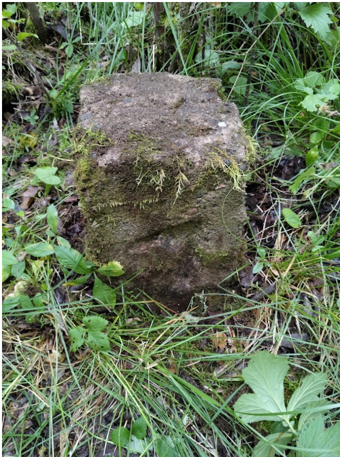
Kuvio 7. Epäselvä numero betonipyykissä
