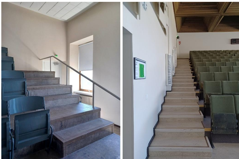
Kuva 13. Kaupungintalon yleisölehterin ja pääkirjaston auditorion porrastetut katsomot
