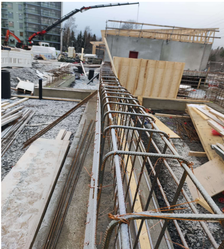
Kuva 3 Paikallavaluseinän raudoitus (Jake Jaakkola 2022)
