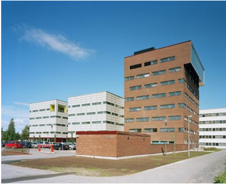
Kuva 3. Toimisto- ja tapahtumatalo Framin D-rakennus (Frami Oy 2025)
