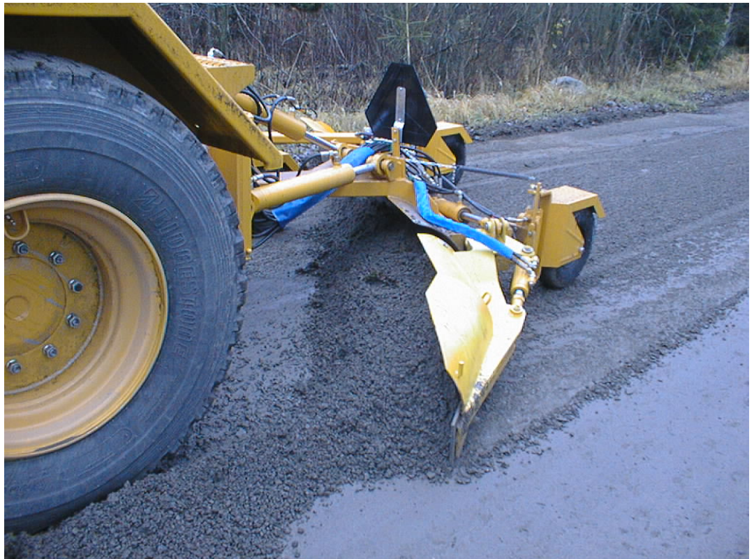
Kuva 22 Karheen aiheuttama voima
