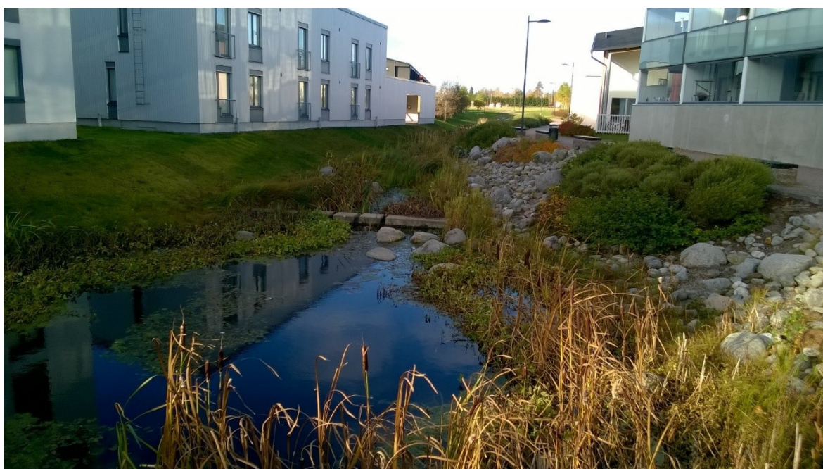
Kuva 3. Hulevesikosteikko Vakanalunen 5.10.2016 (Järvenpään kaupunki)
