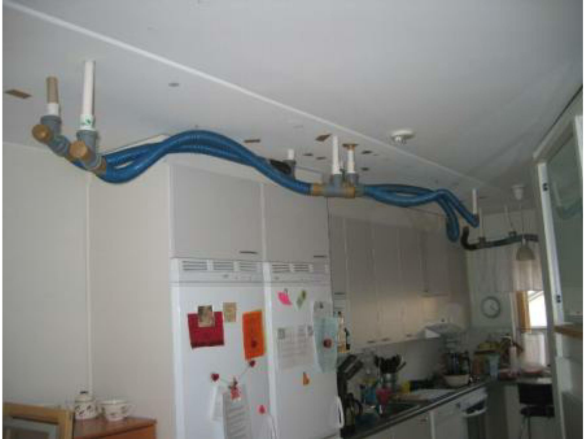
Kuva 9: Kuivatus on käynnissä valmiissa asutussa huoneistossa[14].
