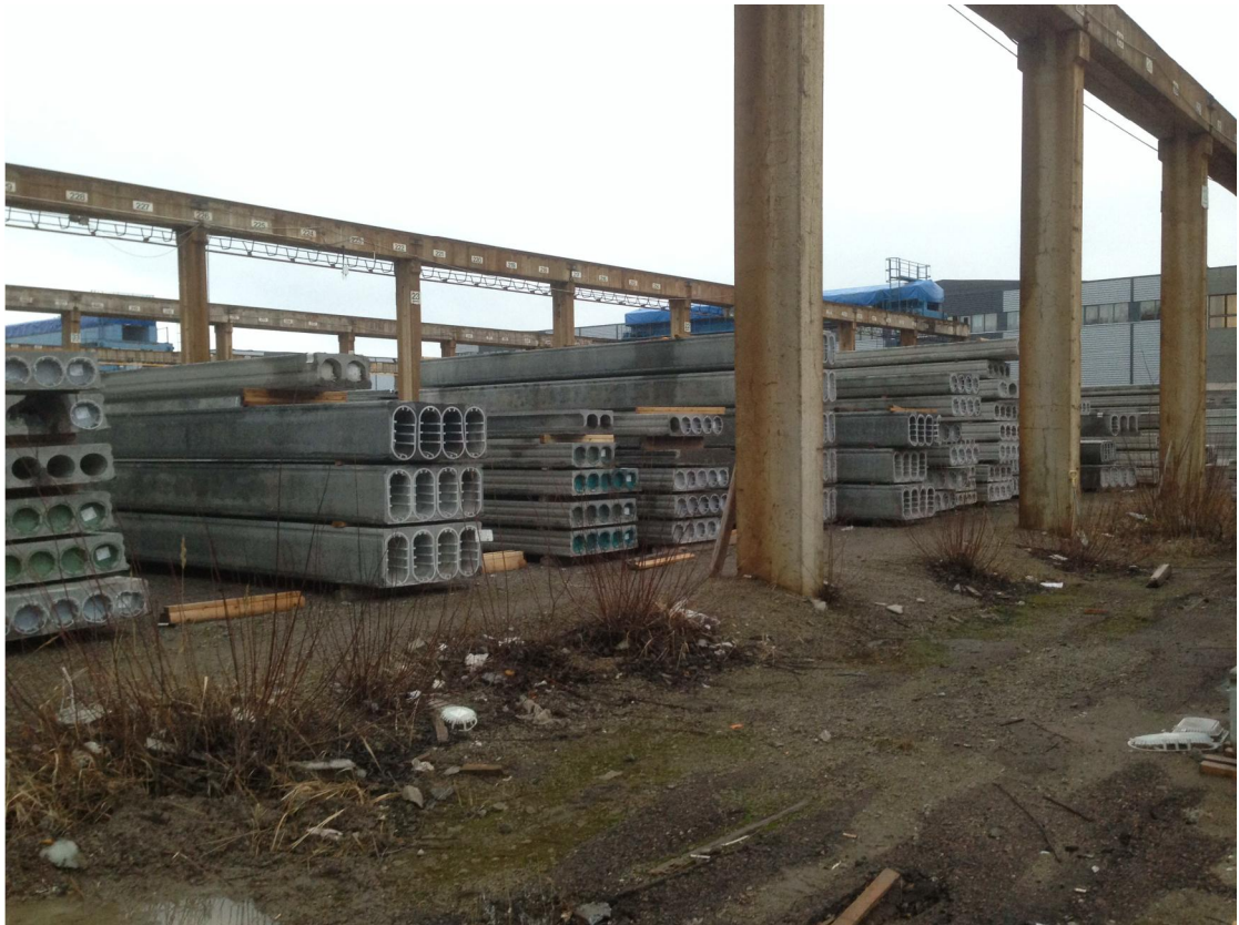
Kuva 6: Elementit saattavat odottaa useitakin kuukausia taivasalla ennen työmaalle toimitusta. Tehtaan varastoalue on useita hehtaareja, joten sen kattaminen toisi suhteettomat kustannukset.
