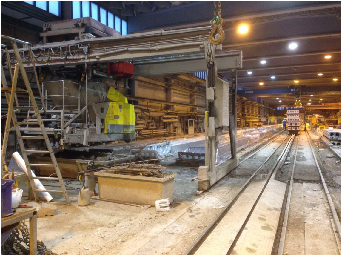
Kuva 1: Ontelolaatat on liukuvalettu ja muovit asetettu päälle jälkihoidoksi halkeilun estämiseksi.
