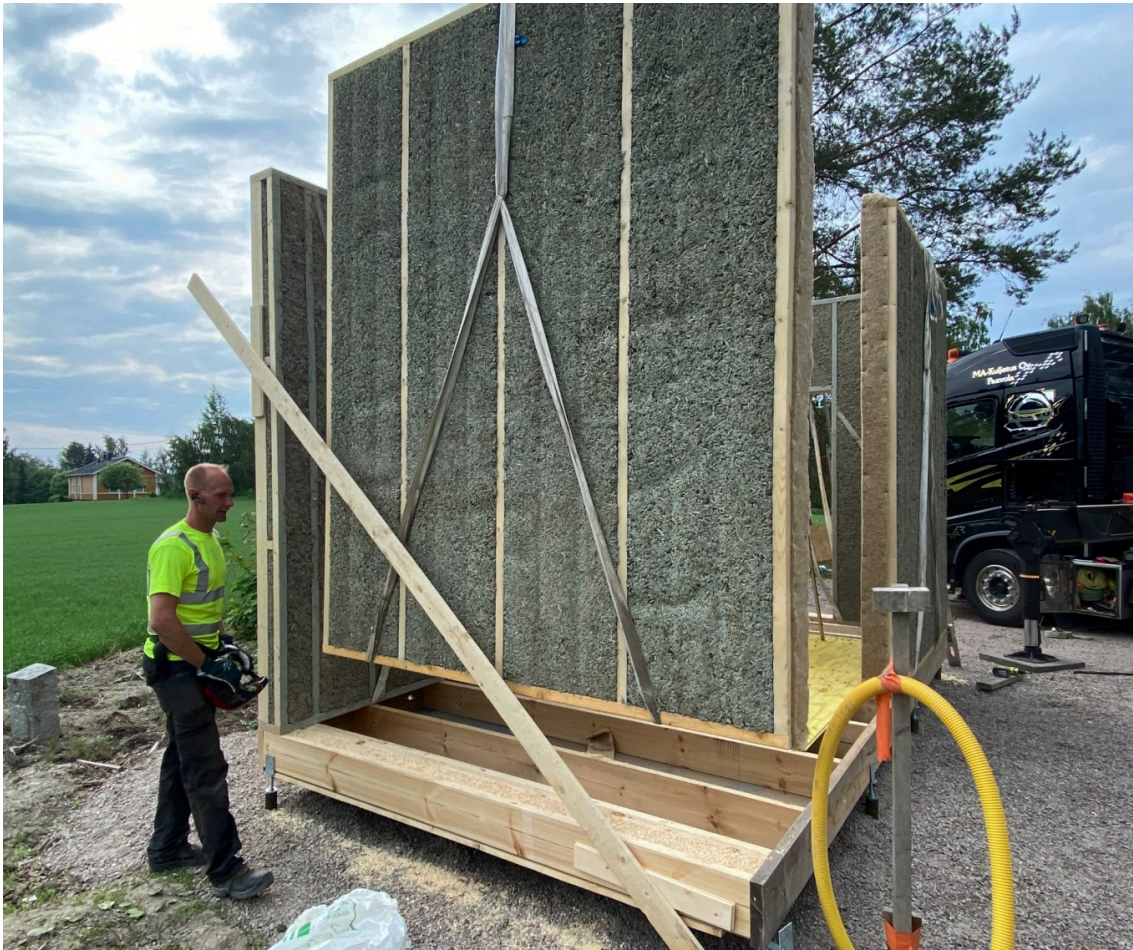
Kuva 3. Kevytsavielementtien kokoaminen rakennuspaikalla (Päätaalo 2023, 4.)
