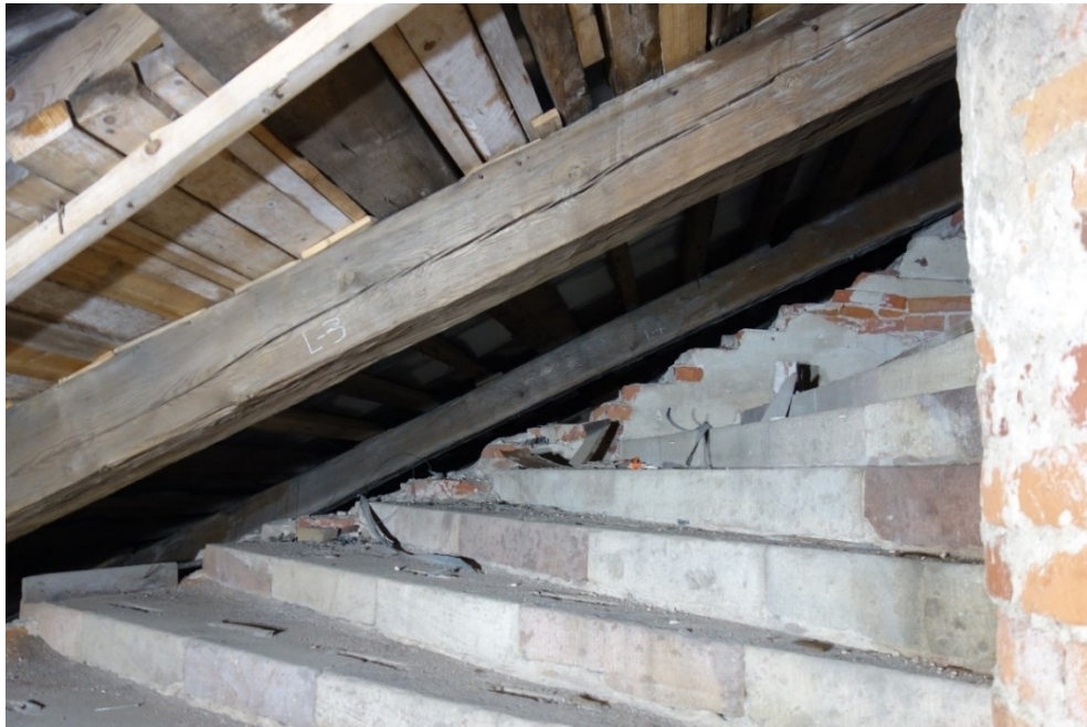
Kuva 84. Läntisen siipirakennuksen neljänteen kerrokseen johtava vanha portaikko
