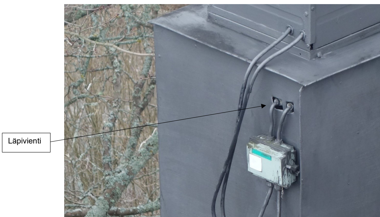
Kuva 63. IV-laitteen kytkintä varten tehdyt läpiviennit hormin kyljessä
