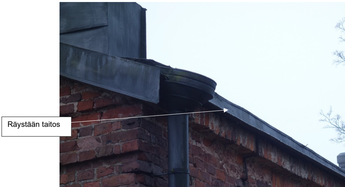
Kuva 83. Lännenpuoleisella lappeella sijaitseva räystääs
