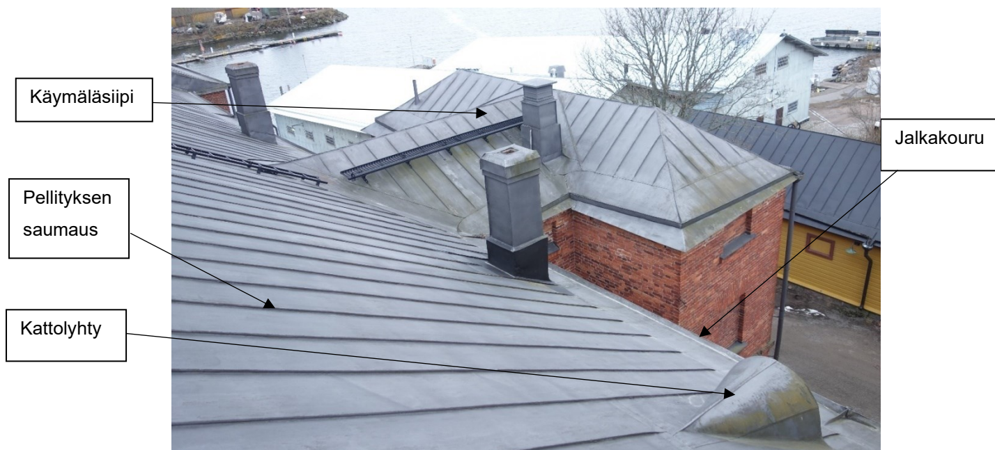
Kuva 34. Yleiskuva läntisen siipirakennuksen lännenpuoleisesta katosta
