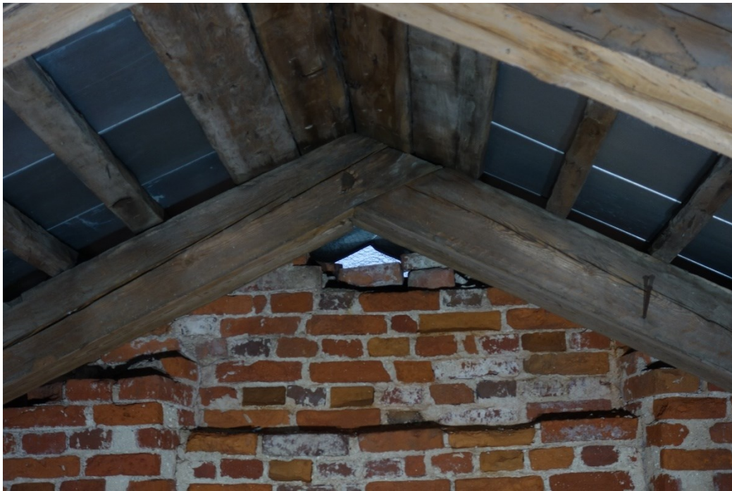
Kuva 82. Pohjoisenpuoleisen päätykolmion yläosaan tehty ilmanvaihtoaukko
