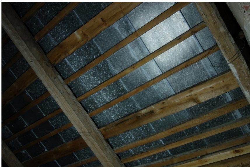
Kuva 43. Vesikaton ja kattotuolien välissä sijaitsevat kattoruoteet
