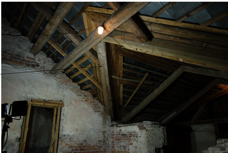
Kuva 47. Käymäläsiiven ja huoneen 305 välissä sijaitsevat jiiripuut
