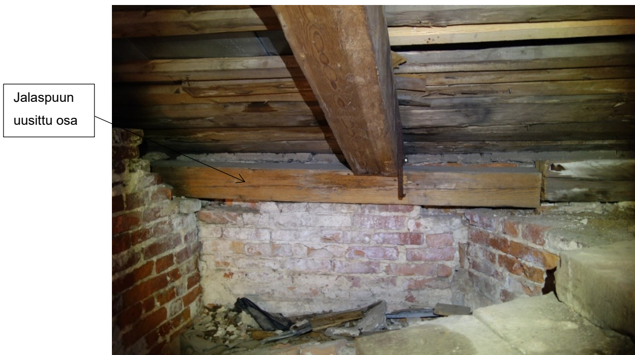
Kuva 53. Jalaspuun pääty on uusittu kolmannen kerroksen lounaispäädyssä.
