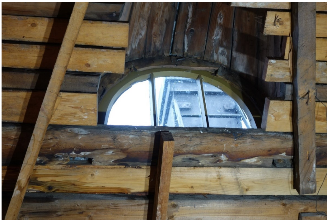
Kuva 35. Huoneessa 314 sijaitseva kattolyhty
