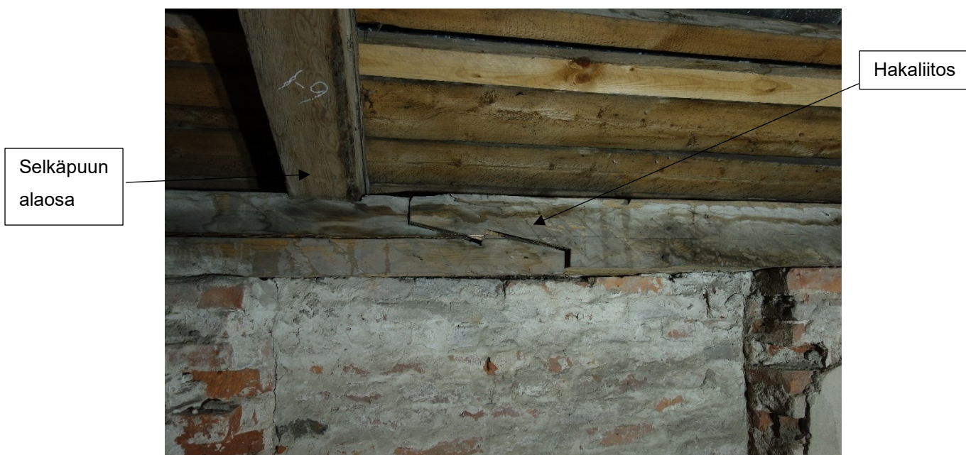
Kuva 42. Ulkomuurin sisäreunaa reunustavat jalaspuut. Jalaspuiden päät on liitetty toisiinsa käyttämällä hakaliitosta.
