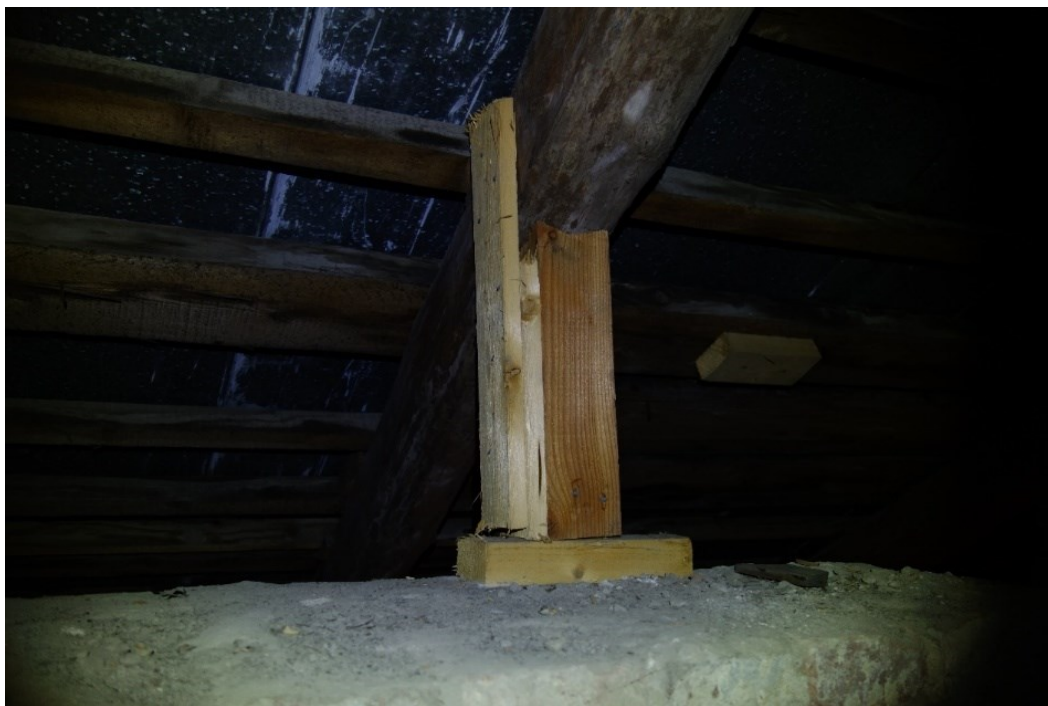
Kuva 51. Neljännen kerroksen selkäpuun pystytuki
