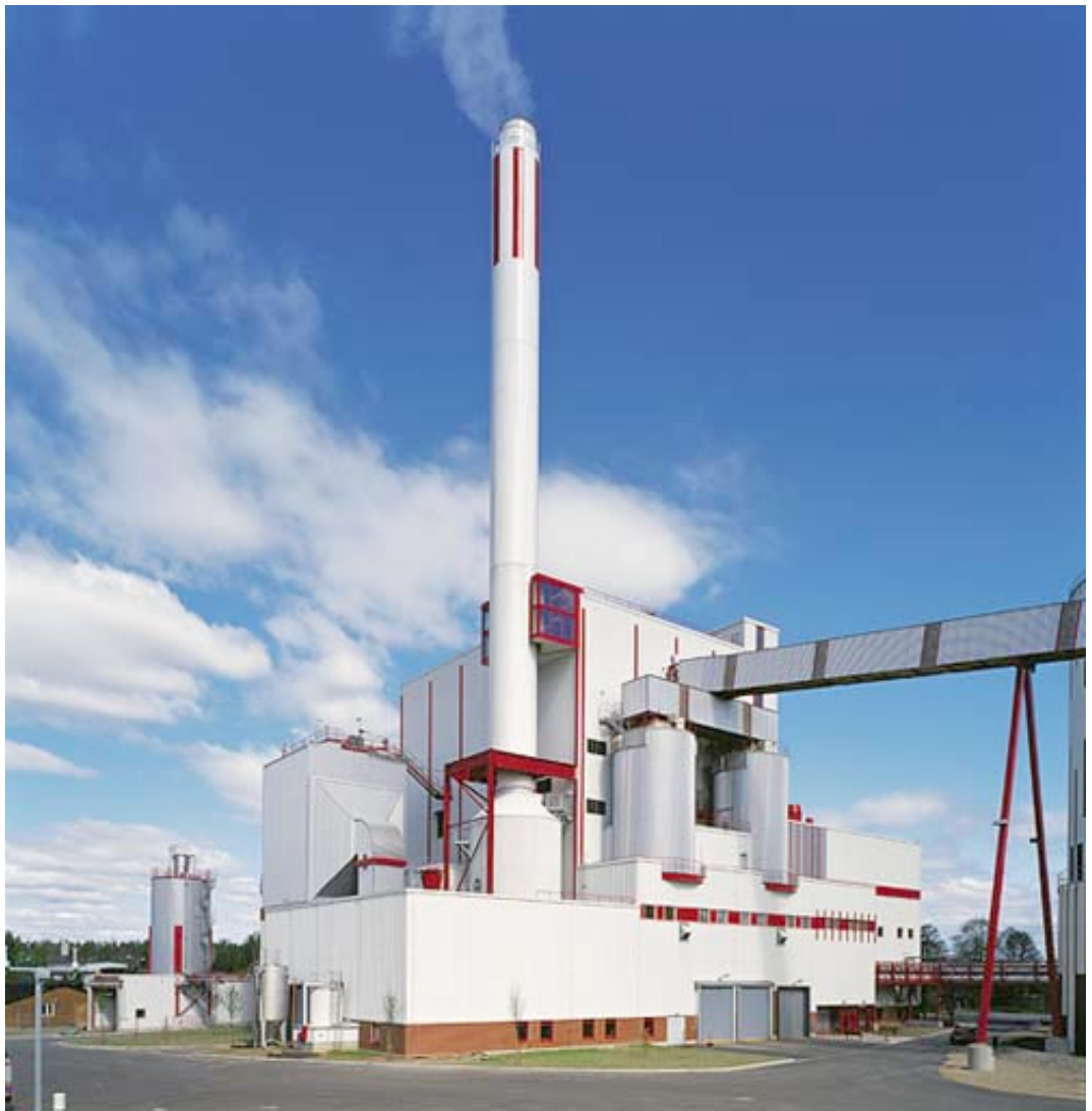
Kuva 4.1. Höyryvoimala, Kvaerner Power Oy.
