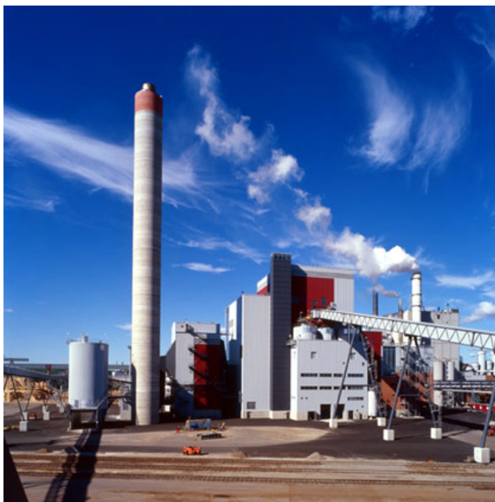
Kuva 2.11. Kvaerner Power Oy:n kattilalaitos.
