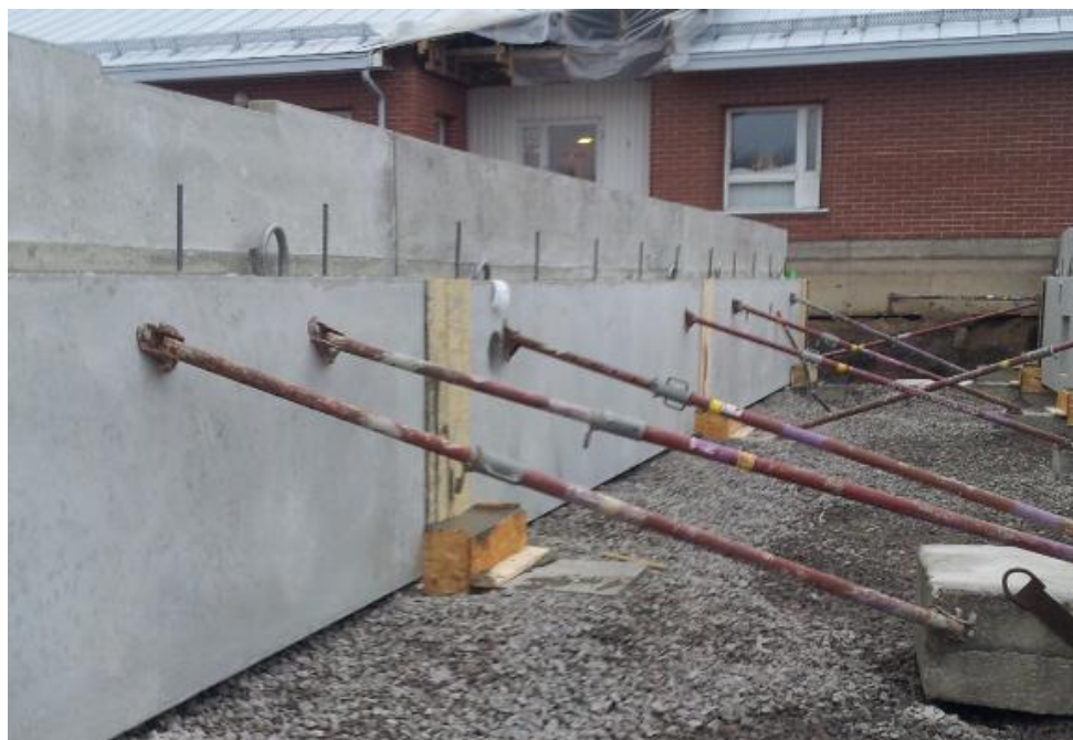
Kuva 4. Sokkelielementit tuetaan säädettävien vinotukien avulla. Tukien yläpään kiinnitysten tulee olla elementin painopisteen yläpuolella. Tukien asentamisessa kiinnitettävä huomiota siihen, että pulttikiinnitykset asennetaan onnistuneesta ja tukien kireydet tarkastetaan.
