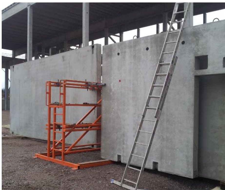
Kuva 7. Seinäelementtejä varastoituna kampatelineeseen. Kampatelineeseen varastoitaessa tulee kiinnittää huomiota asennusjärjestykseen, elementtien tuentaan ja aluspuiden paikkojen määrittämiseen.
