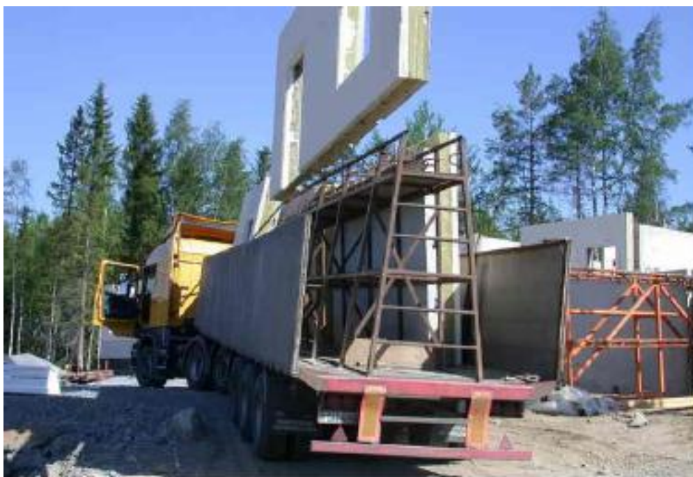
Kuva 6. Kuorman purku A-pukista, elementit tulee nostaa vuorotellen pukin molemmilta puolilta. Työmaalle saapuvien elementtien välivarastointiin voidaan myös käyttää A-pukkia. [3.]
