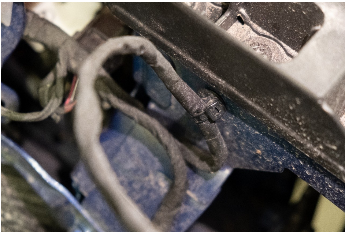
Kuva 5. ID.5 -johtosarjan kangasteippisuojaus.
