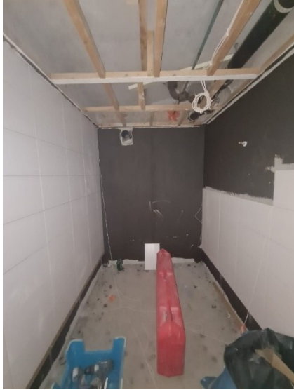
Kuvio 9. Kylpyhuoneen laatoitus käynnissä linjasaneeraushankkeessa
