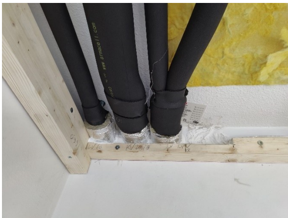
Kuvio 10. Huoneistoon menevien putkien läpiviennit tiivistetty asianmukaisesti paloakryyllillä, sekä lisätty palokatkon merkintätarra, joka ilmoittaa mitä tuotetta tässä on käytetty
