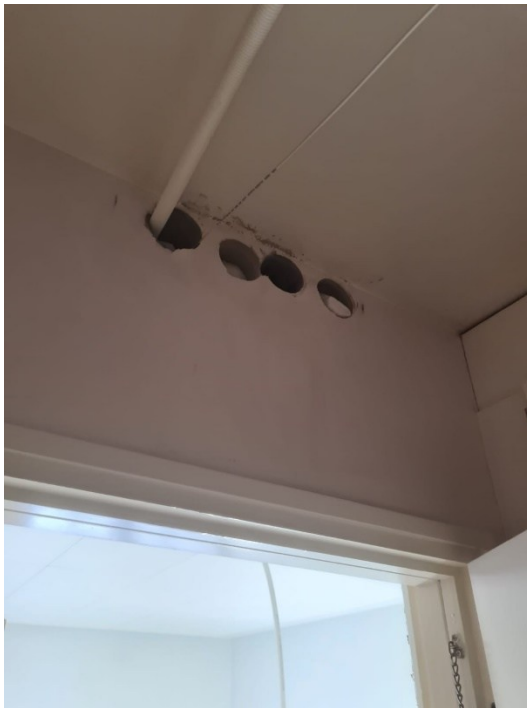
Kuvio 4. Kylpyhuoneeseen poratut läpivientireiät uusille vesijohdoille
