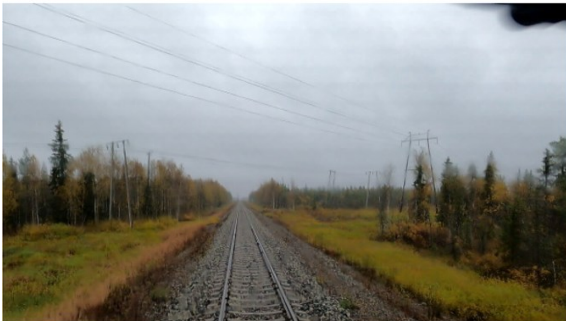
KUVA 4. Radan sähköistykseen liittyvä maastokatselmus (Sweco 2024)
