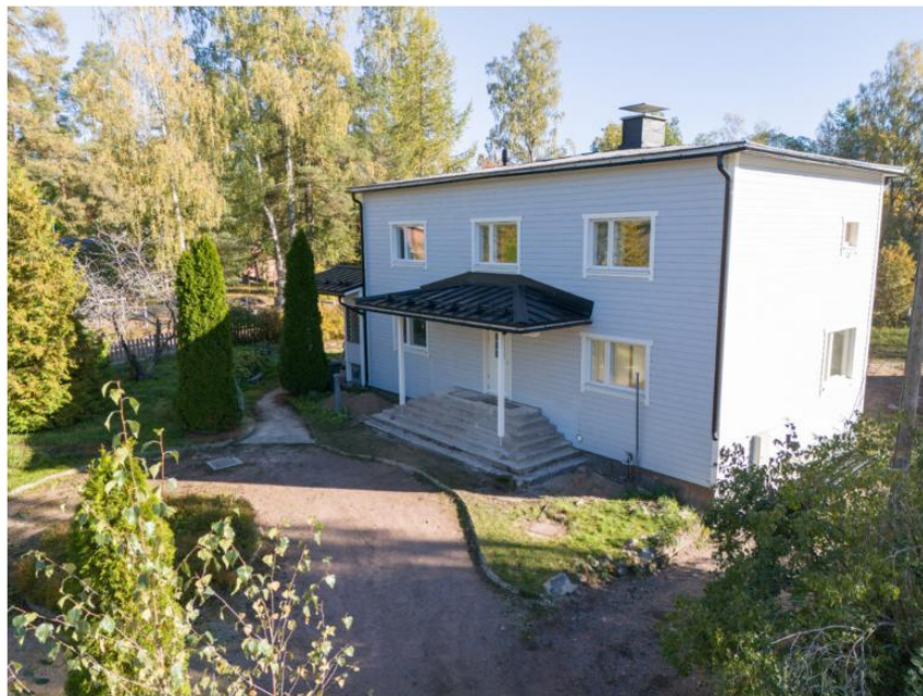
Nurmijärvellä syksyllä 2024 valmistunut saneerauskohte.
