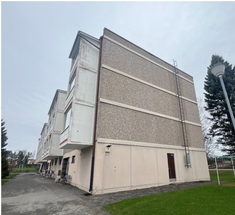
Kuva 8. Julkisivun kaakkoispäädyn pellitykset.
