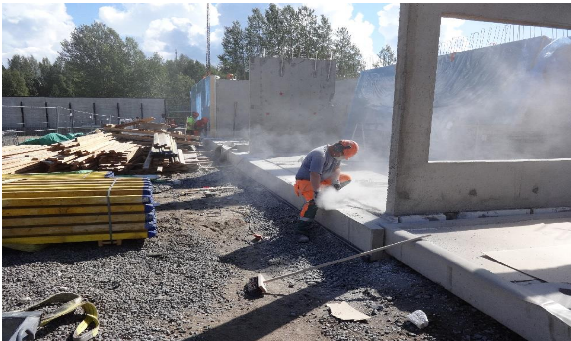
KUVA 5. Asennuksen valmistelu (Kuokkanen 2014-07-19). Ennen puujulkisivuelementtien asennusta sokkeli käydään tarkasti läpi timanttilaikalla ajamalla sokkeli muutaman millin alle elementin lähtököron ja poistamalla rosot.
