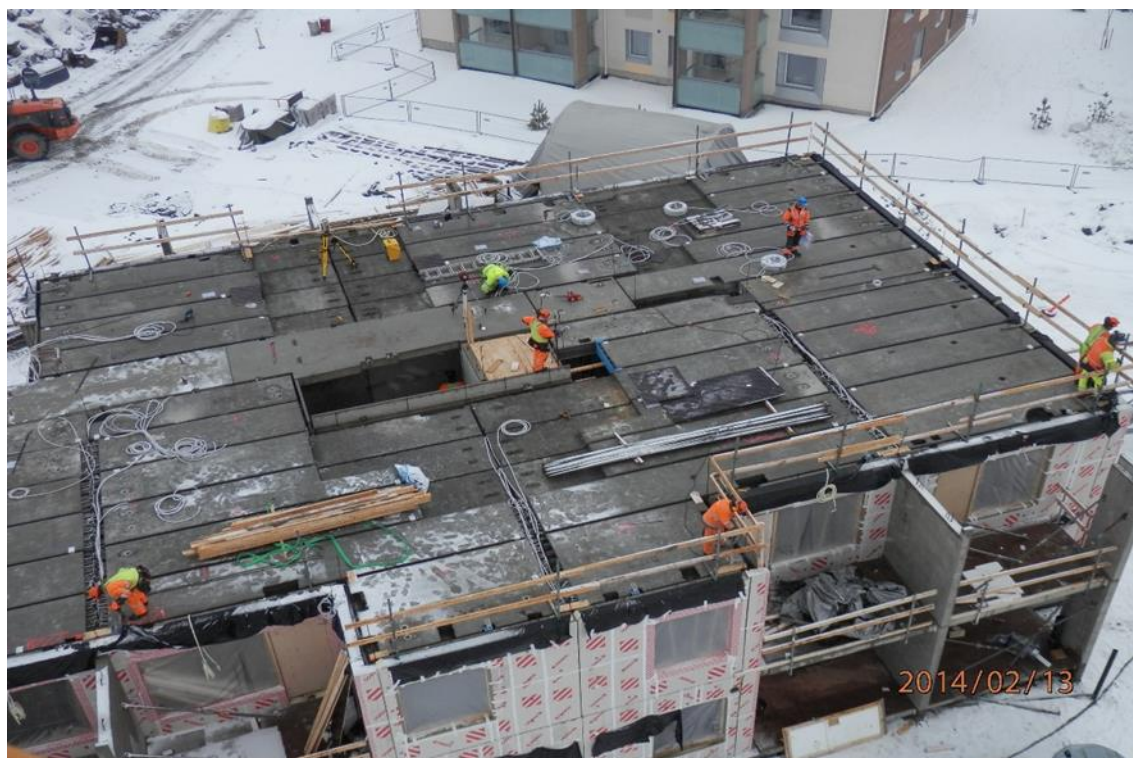
KUVA 3. Elementtien asennus on alkamassa (Sällilä 2014-02-13). Ontelolaattakenttä on asennettu. Mittamies (kuvan keskellä) merkkää asennettävien elementtien paikkoja. Asennusryhmä (kuvan oikea laita) miettii elementtien asennusjärjestystä elementtivakista.
