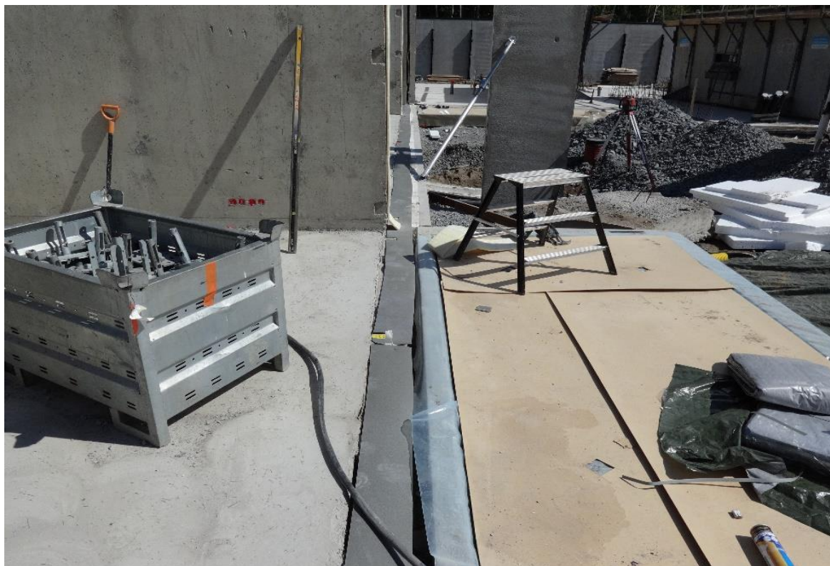
KUVA 7. Puujulkisivuelementti on valmis asennettavaksi paikoilleen (Kuokkanen 2014-07-19). Asennusryhmä on puhdistanut sokkelin yläpinnan ja asentanut 3 mm paksun routaeristeen ja korkopalat.
