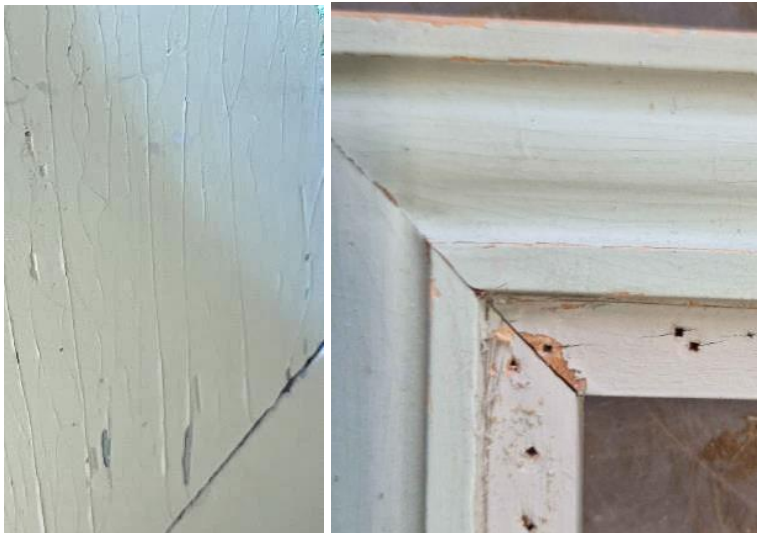
Kuva 12 Vasemmalla krakeloituneen maalipinnan alta näkyvä harmaa maali ja oikealla tuolin nykyinen ja alkuperäinen maalipinta
