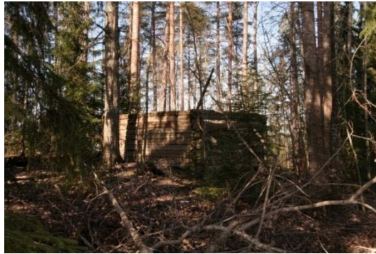
Kuva 49. Romahtanut hirsinen vaja talousrakennuksen (lato/kalustevaja) pohjoispuolella metsässä.
