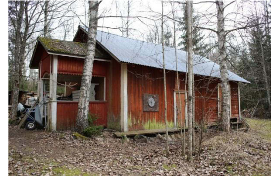
Kuva 63. Koivurinteen kiinteistön varastorakennus (ent. vilja-aitta) kuvattuna kohti etelää. Rakennus sijaitsee Koivurinteen pihapiirissä.
