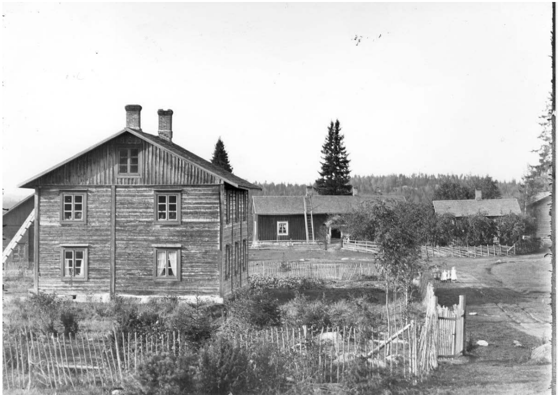
Kuva 15. Jussilan tilan rakennuksia kuvattuna 1900-luvun alussa (Jousi 1900–1911)
