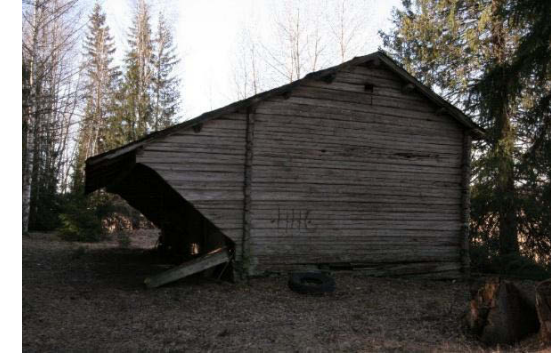
Kuva 39. Jussilan tilan riihi kuvattuna Aittakalliontien puolelta lounaaseen.
