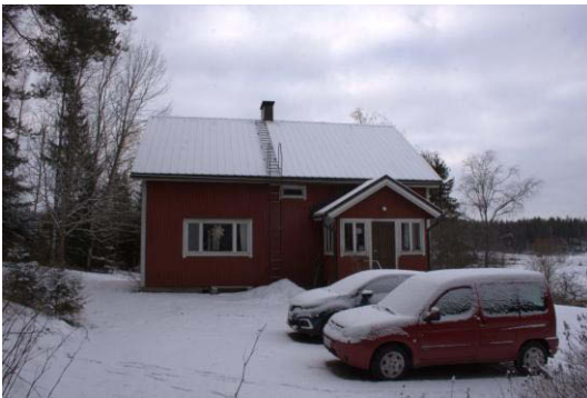
Kuva 74. Tyynelän asuinrakennus kuvattuna lounaaseen
