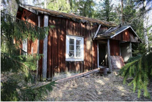
Kuva 32. Syytinki ja työväenasunto kuvattuna kohti pohjoista.
