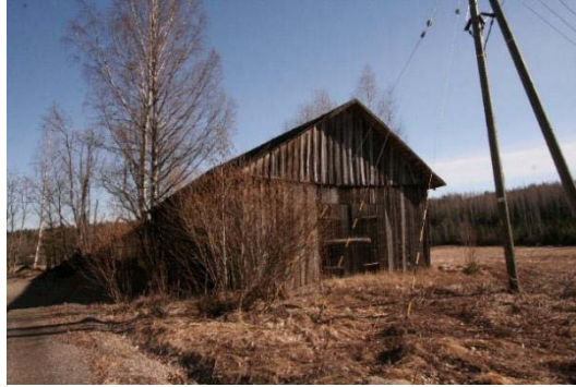
Kuva 42. Jussilan tilan talousrakennus (heinälato) kuvattuna itään. Rakennus on pellon reunassa Aittakalliontiestä haarautu- van paineenkorotusasemalle päättyvän tien itäpuolella. Raken- nuksen edustalla sähköpylväät.
