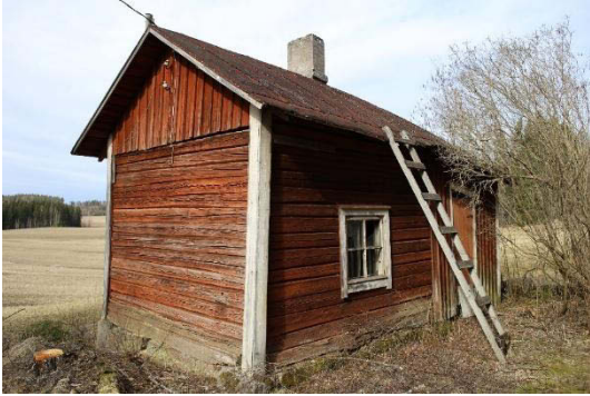
Kuva 64. Koivurinteen kiinteistöön kuuluva Aittakalliontien pohjoispuolelle sijoittuva vanha saunarakennus kuvattuna kohti pohjoista.
