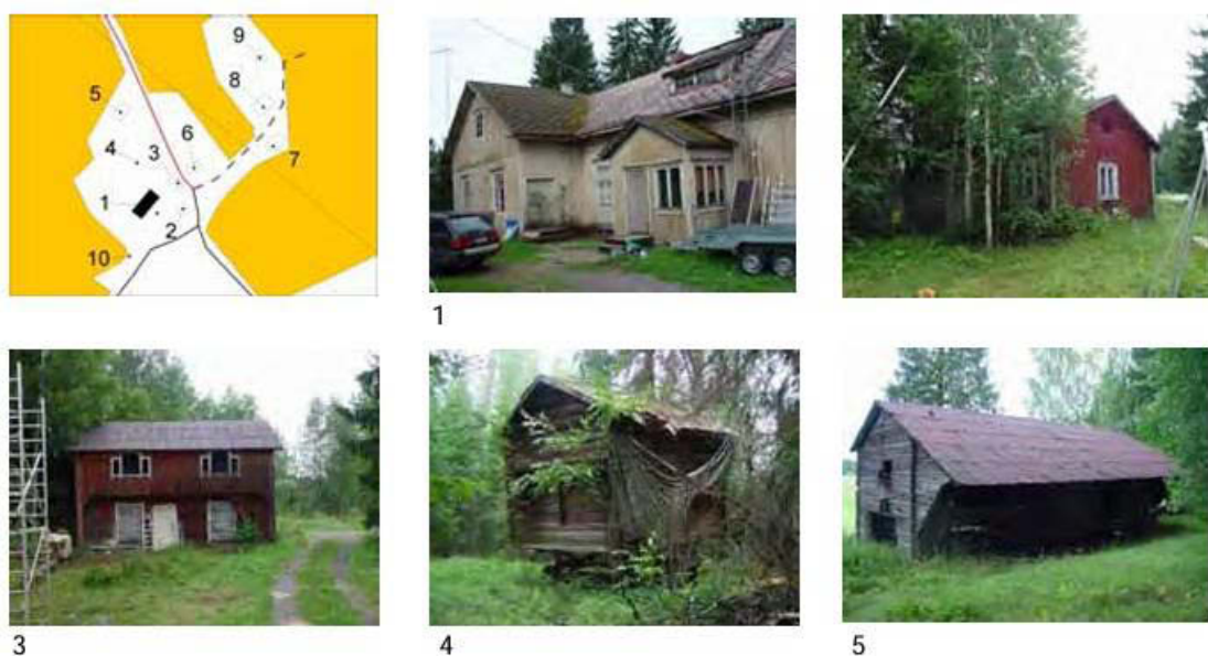
Kuva 9. Jussilan rakennuksia (Nurmijärven rakennusperintöselvitys 2010)
