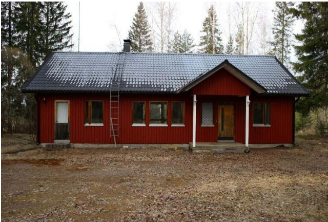
Kuva 58. Kurrelan kiinteistön päärakennuksen julkisivu kuvattuna luoteeseen.
