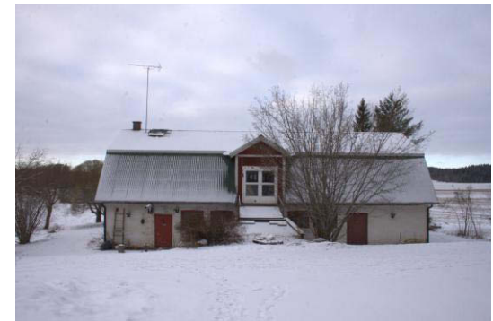
Kuva 76. Aittakallion ateljeen julkisivu kuvattuna asuinrakennuksen edustalta luoteeseen
