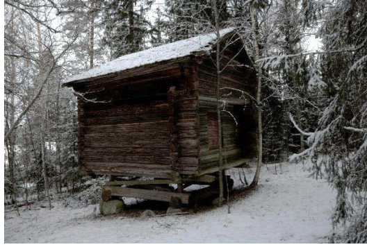
Kuva 35. Jalka-aitta kuvattuna kohti pohjoista.
