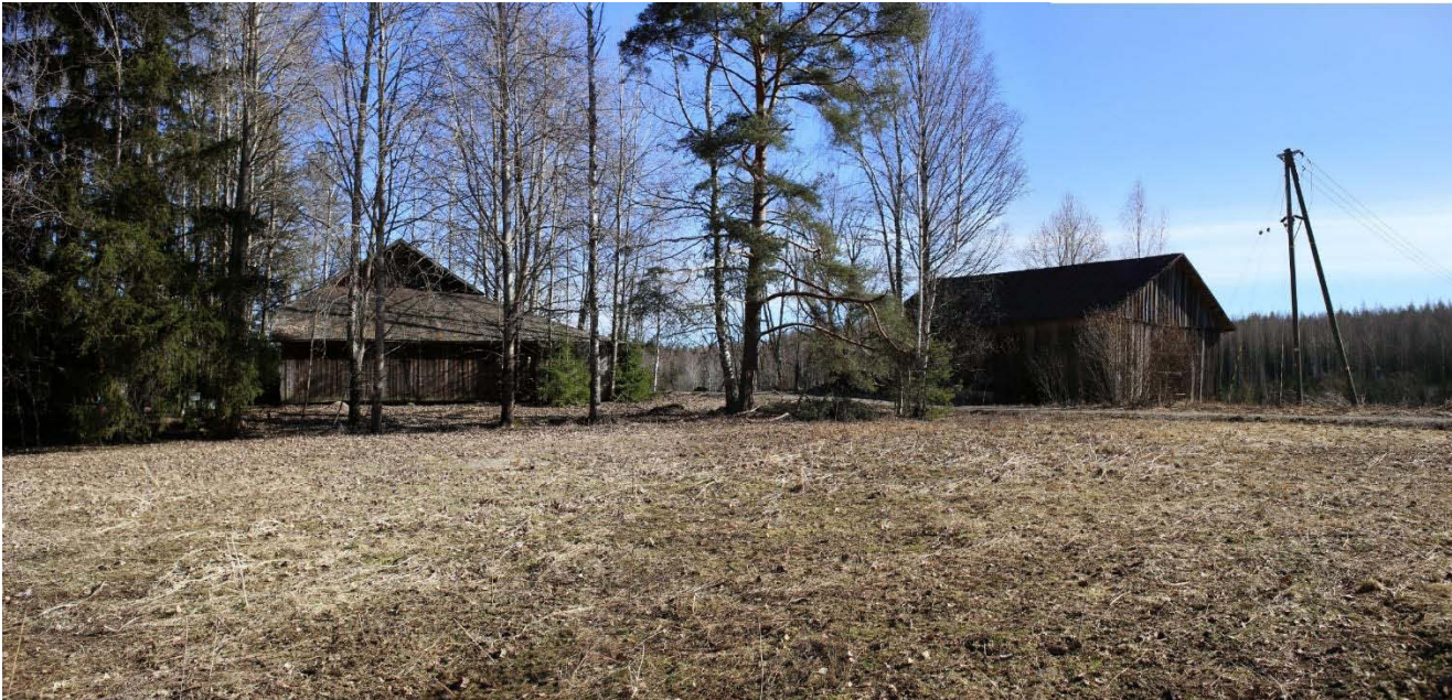
Kuva 57. Kuvassa Jussilan tilan talousrakennuksia (kalustevaja/lato ja heinälato), kuvattuna pohjoisen suuntaan. Rakennusten välissä kulkee sorapäälysteinen tie.
