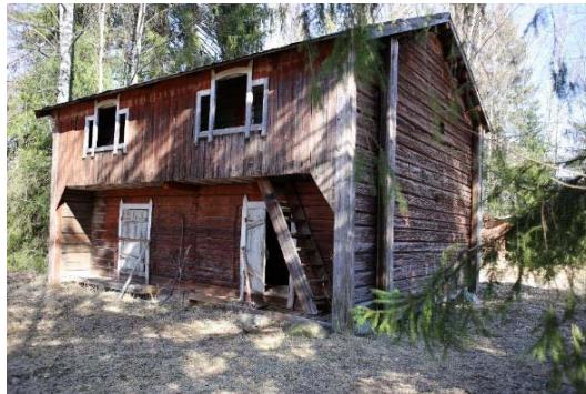
Kuva 30. Jussilan tilan luhtiaitta kuvattuna kohti pohjoista. Luhtiaitan takan näkyy Aittakalliontien toisella puolella oleva halkovaja.
