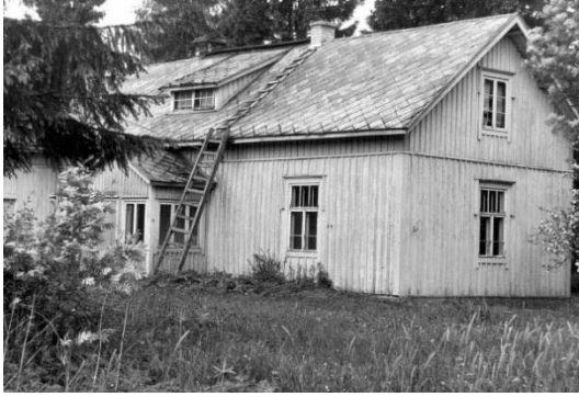
Kuva 16. Jussilan tilan päärakennus (Högman 1987)
