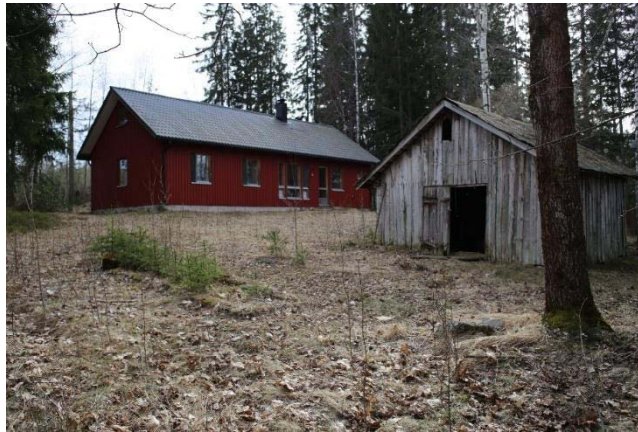
Kuva 59. Kurrelan kiinteistön päärakennus talousrakennus/vaja. Vaja sijoittuu pihassa päärakennuksen ja Aittakalliontien väliin.
