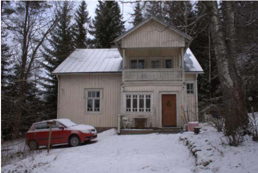
Kuva 61. Koivurinteen päärakennuksen eteläinen julkisivu.
