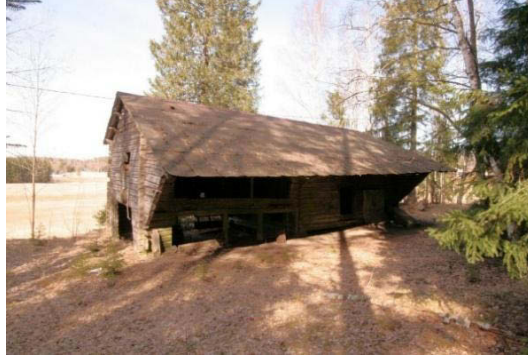
Kuva 37. Jussilan tilan riihi kuvattuna kohti pohjoista, riihi sijaitsee Jussilan tilan metsäsaarekkeen luoteisreunalla.
