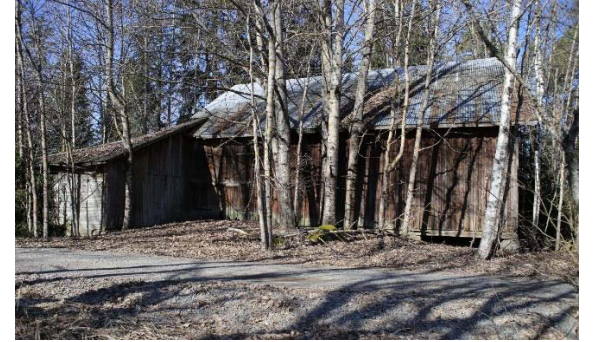
Kuva 44. Jussilan tilan talousrakennus (lato/Kalustevaja) kuvat- tuna länteen.
