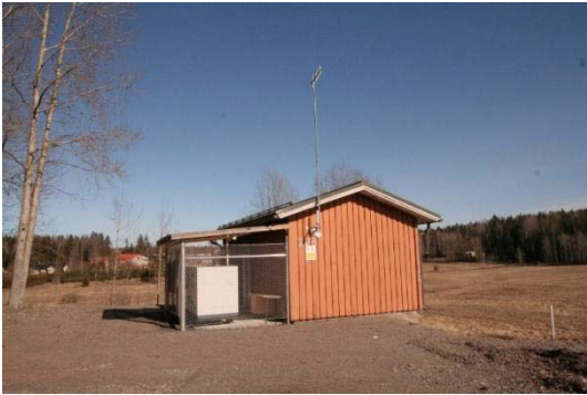
Kuva 47. Paineenkorotusasema kuvattuna pohjoiseen. Taustalla maisemassa Lähilammentien kiinteistöjen rakennuksia.
