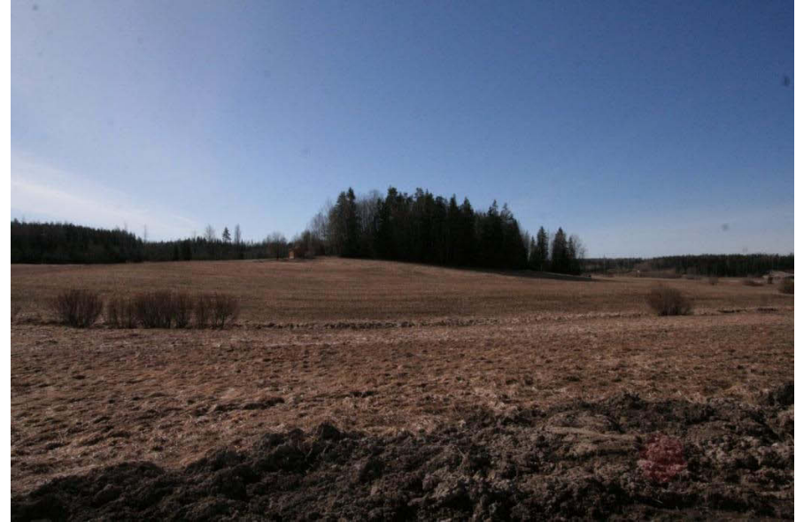
Kuva 9. Lähilammentietä kohti etelää. Kuvassa peltomaisemaa, jonka keskellä poikittaissuunnassa kulkee luhtioja. Kuvassa keskellä on Jussilan tilan metsäsaareke, jonka vasemmalla puolella on paineenkorotusasema.
