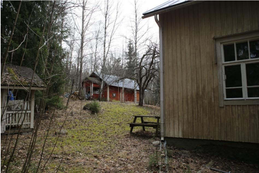
Kuva 71. Kuvassa Koivurinteen kiinteistön rakennusten välisiä suhteita. Kuva pihan pohjoisnurkalta, vasemmalla kuvassa leikkimökki, keskellä rinteessä varasto (ent. vilja-aitta) ja oikealla asuinrakennus.
