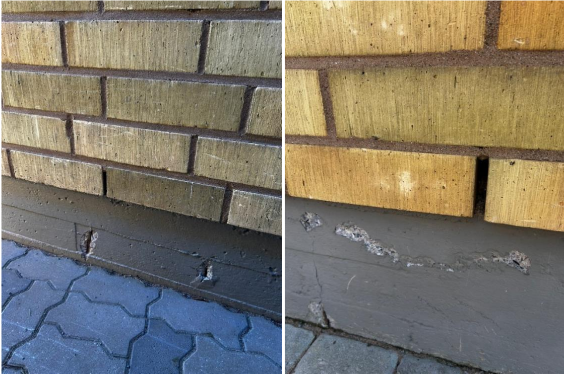
KUVA 29. Raudoitukset näkyvät kuluneen sokkelin alta.
