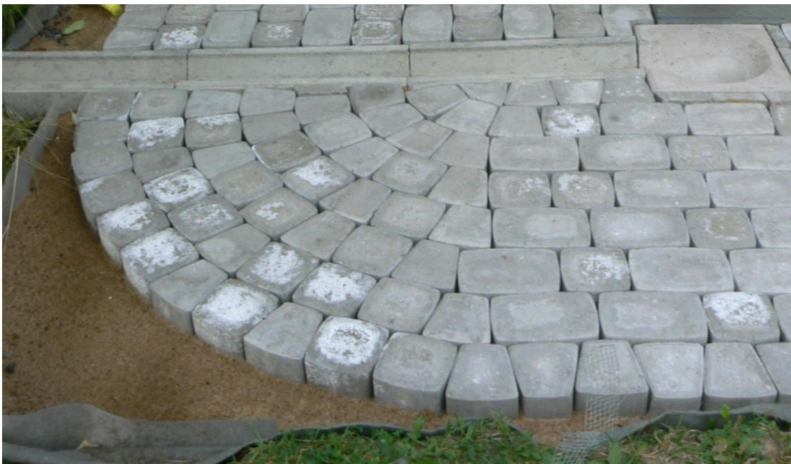
KUVA 15. Uuden kivetyksen asennus. (Salo J. 7.2010)
