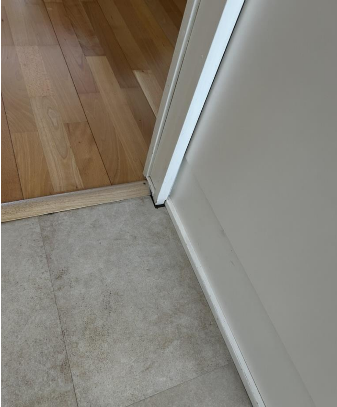
KUVA 37. Keittiön ja olohuoneen lattiat.
