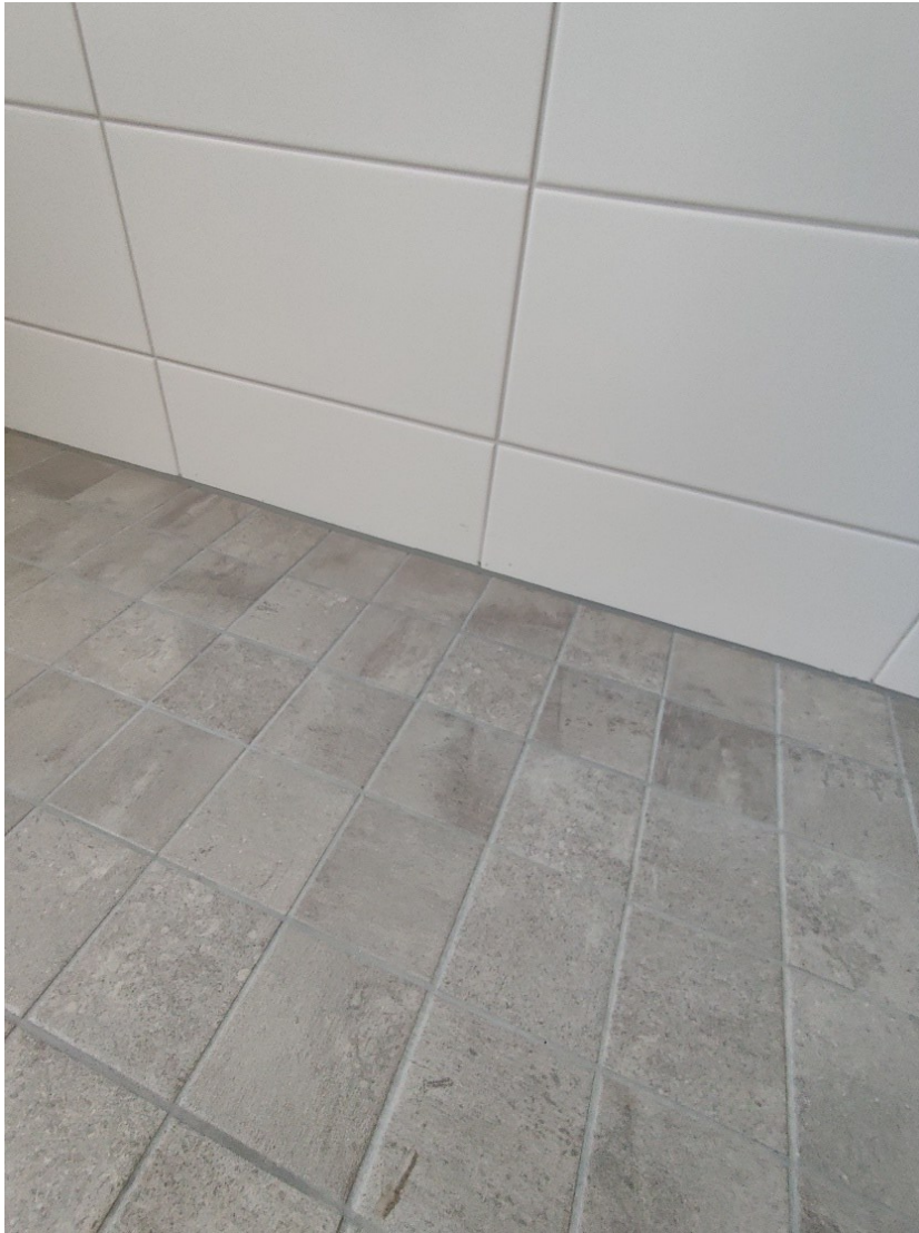
Kuva 2. Remontoitu kylpyhuone M2-Kotien kohteesta Lahdesta
