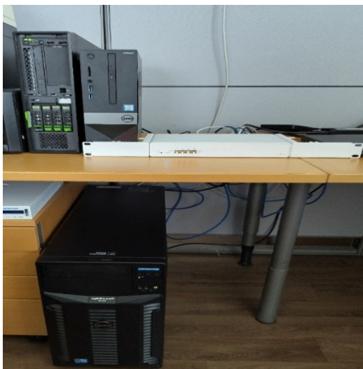
Kuva 3. Rakennettu fyysinen testiympäristö.
