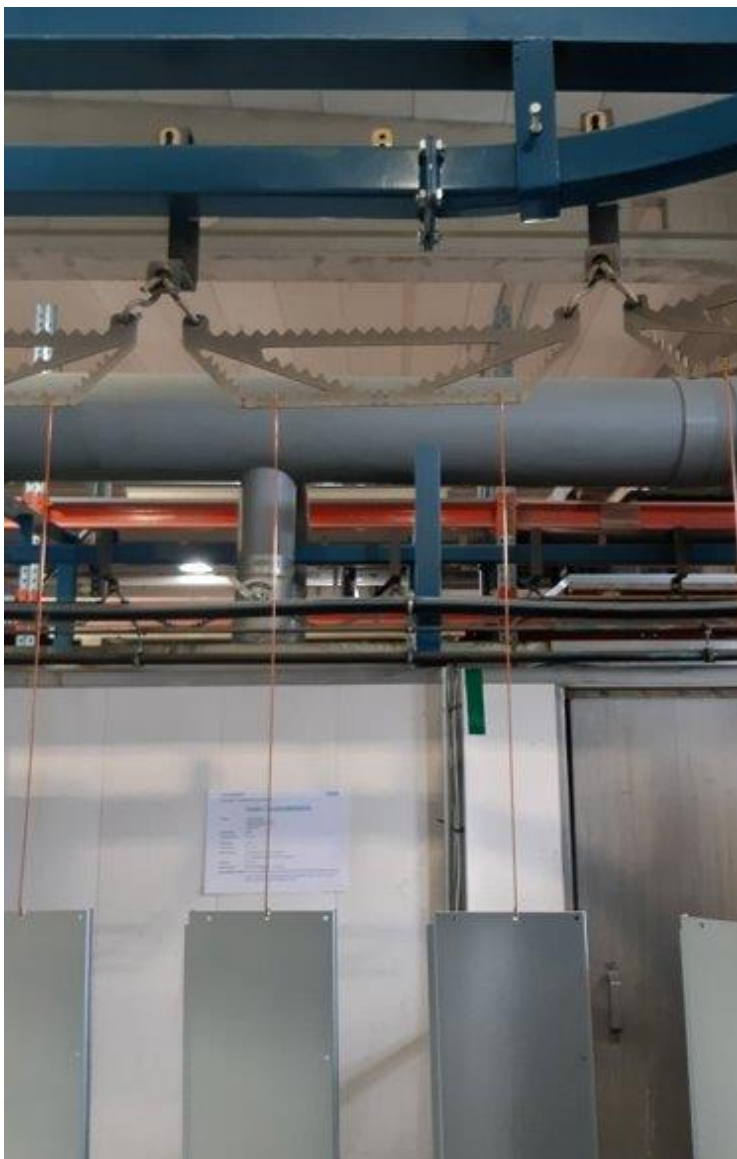
Kuva 3. Maalattavia kappaleita ripustettuna metallikoukkuihin (Turunen 2022.).
