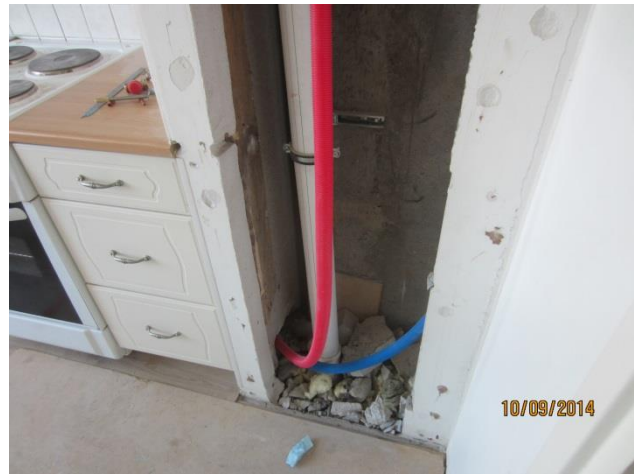
2. Uudet vesijohdot ja viemäri
