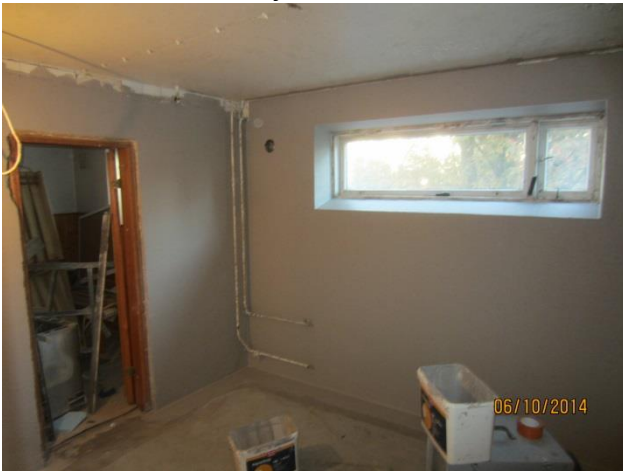
9. Talonyhtiön pesuhuoneen seinät vesieristetty
