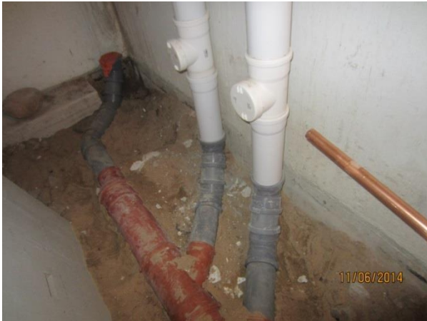
KUVA 11. Uusi runkoviemäri asennettu kellariin
