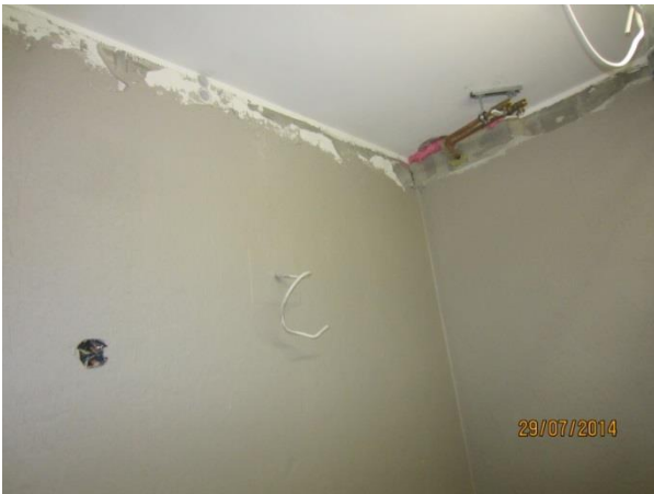
KUVA 15. Seinät vesieristetty
