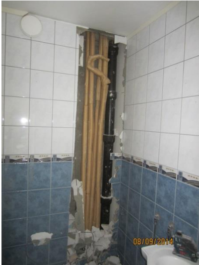
1. Pesuhuoneen putkihormi aukaistu
