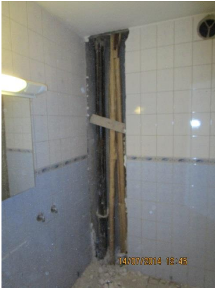
KUVA 12. Auki piikattu pesuhuoneen putkistohormi
