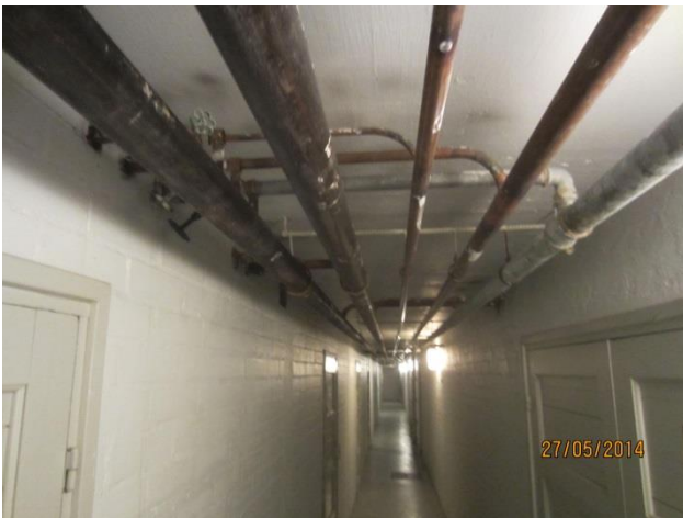
3. Asbestieristeet poistettu
