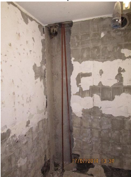
3. Asbestieristys poistettu
