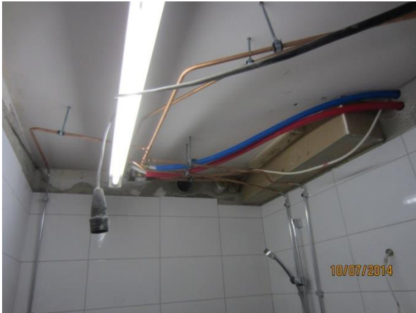
KUVA 16. Seinät laatoitettu ja alaslaskukaton teko aloitettu
