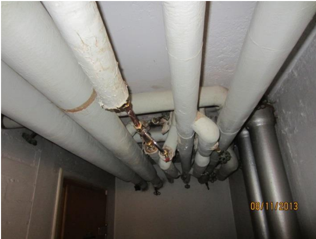
1. Putkistoissa asbestieriste
