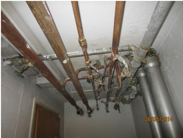
KUVA 10. Asbestieristykset purettu kellarissa
