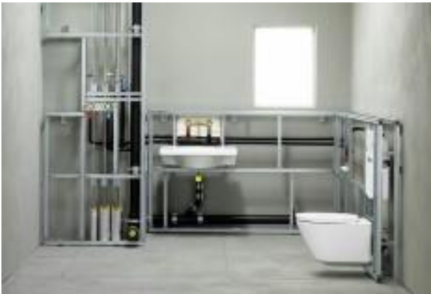
KUVA 3. Geberit GIS-asennusseinä (16)
