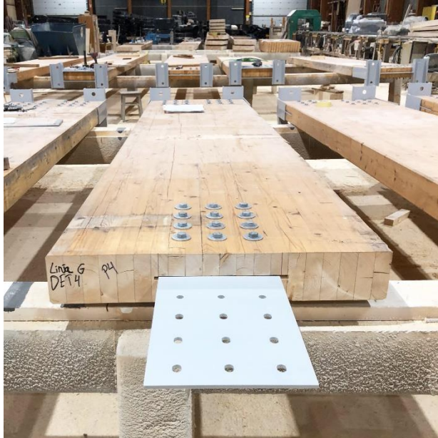
Kuva 21. Turun Late-Rakenteilla asennettiin tappivaarnaliitos purettuihin liimapuihin (Spolia Design Oy)
