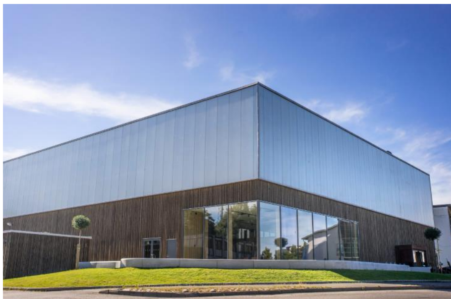
Kuva 25. Mölnlycken padelhalli (Puuinfo Oy 2022)
