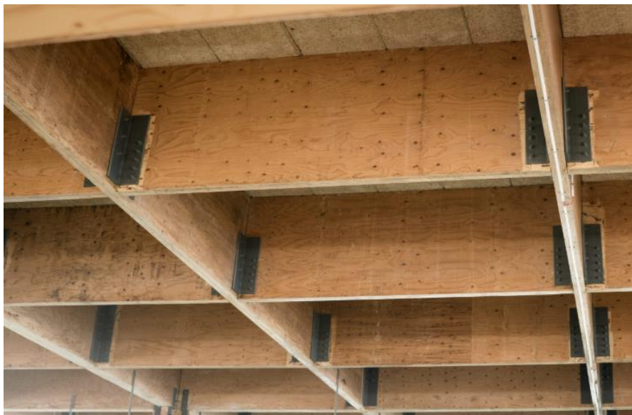
Kuva 27. Ristikkomuotoon asennetut Kerto LVL-palkit (Puuinfo Oy 2022)
