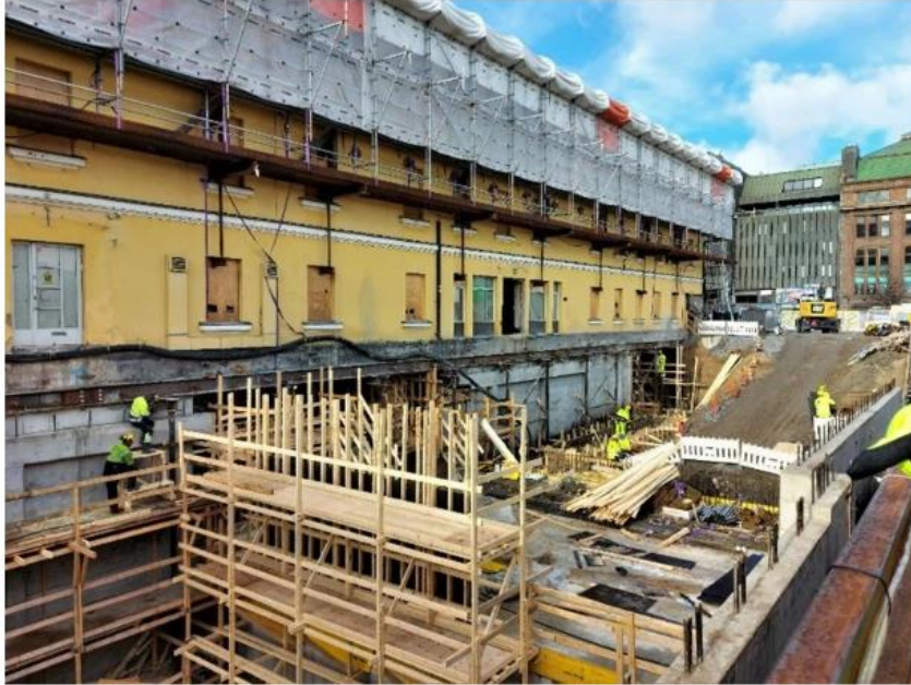
Kuva 29. SRV:n Helsingin Lasipalatsin aukion työmaa (Puuinfo Oy 2023)
