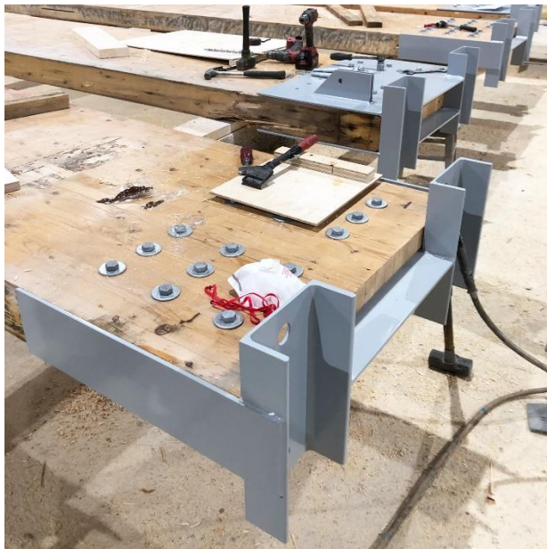
Kuva 22. Turun Late-Rakenteilla asennettiin pilarikenkä purettuihin liimapuihin (Spolia Design Oy)
