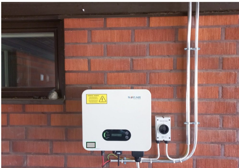
Kuva 7. Yleiskuva invertterin asennuksesta
