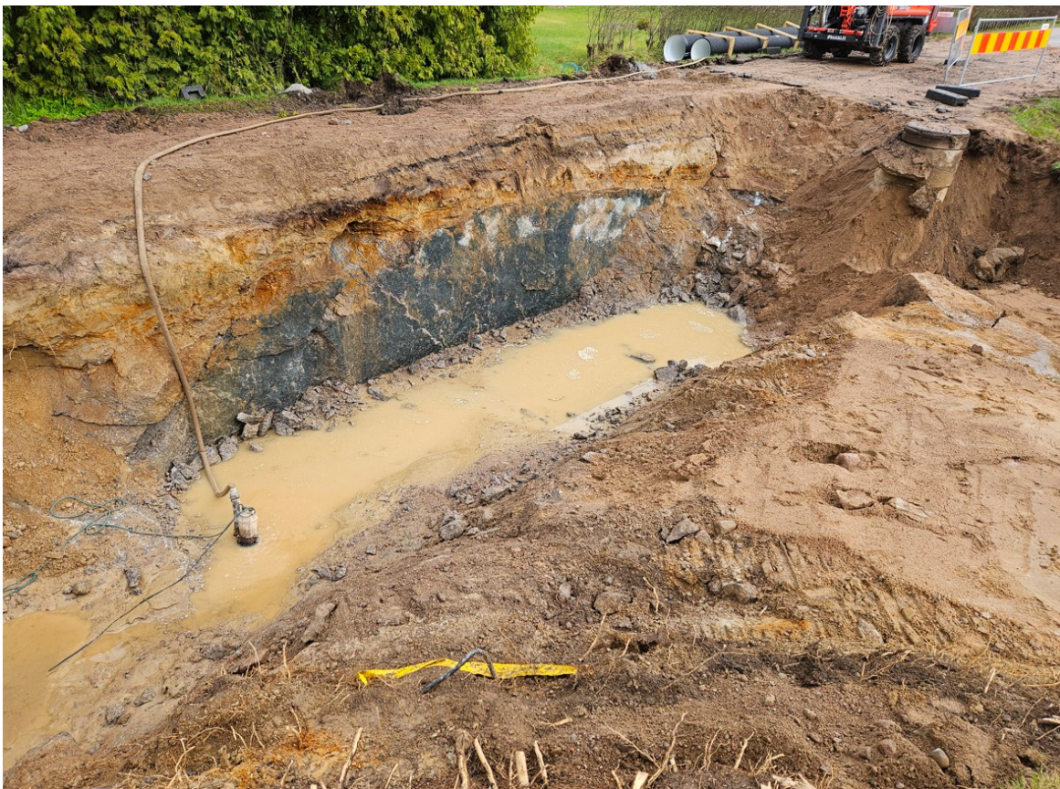
Kuva 4. Uppopumppu käytössä saneeraustyömaalla.
