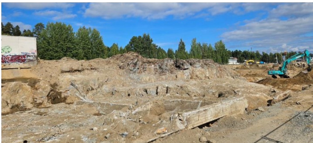
Kuva 1. Louhittavaa kalliota K-Citymarket Kuopio työmaalta.
