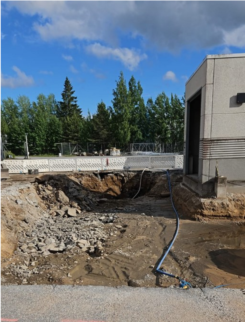
Kuva 7. Postin terminaalin laajennustyömaa, jossa on kaivettu, tiivistetty ja louhittu rakennuksen vieressä.
