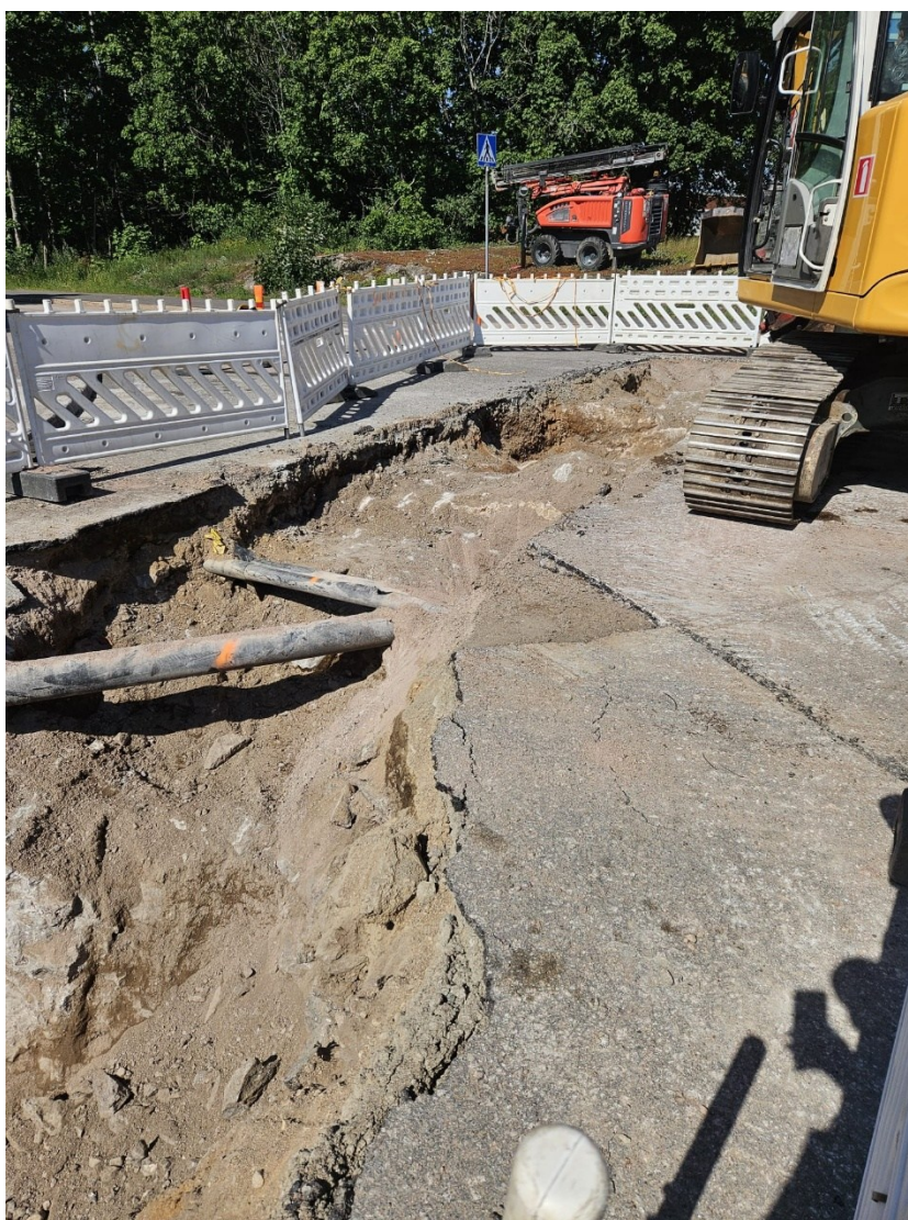
Kuva 2. Louhittavaa kalliota katusaneeraustyömaalta.
