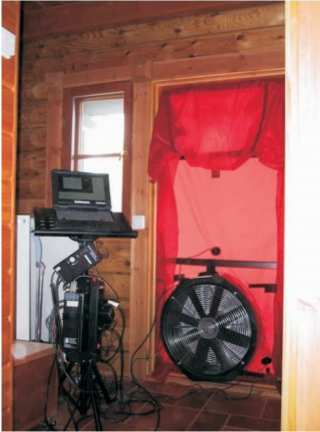
Kuva 6. Painekoelaitteisto ulko-oveen asennettuna. (RT 80-10974, 13).
