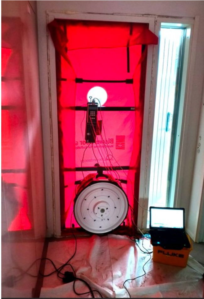
Kuva 15. Minneapolis-tiivysmittauslaitteisto asennettuna oviaukkoon.
