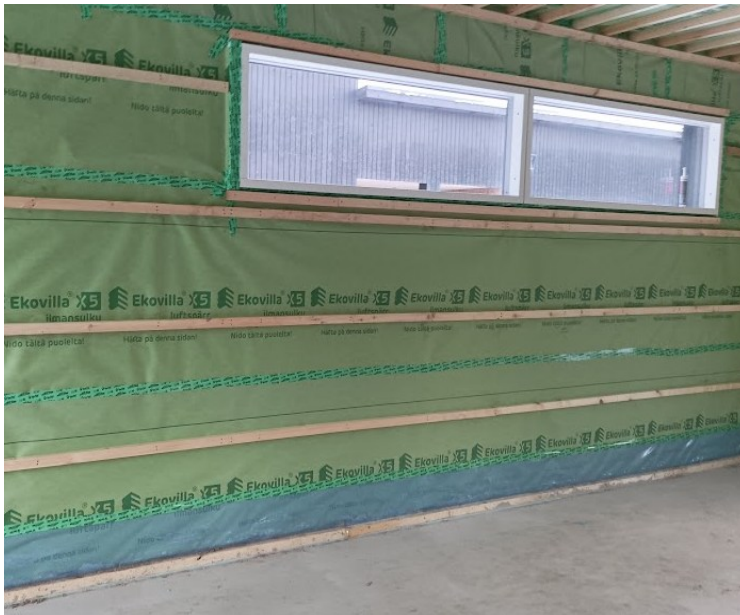
Kuva 11. Ilmansulkuparin saumat tiivistetty teipillä.
