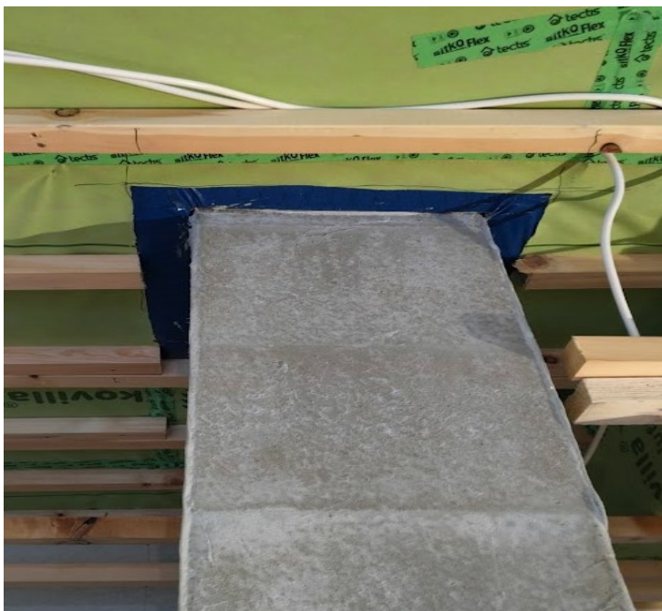
Kuva 12. Hormin ja ilmansulkupaperin tiivistys Tescon No 1 tiivistysteipillä.
