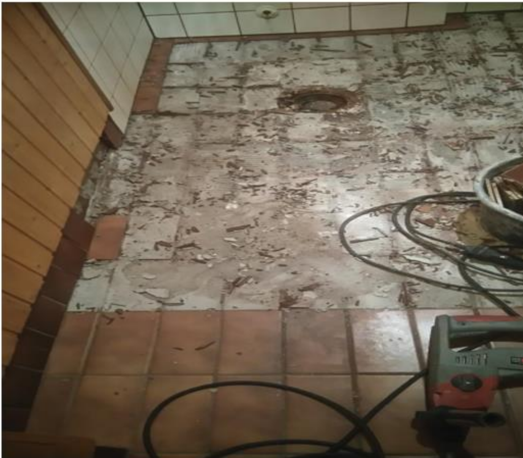
KUVA 4. Lattian pintarakenteen purku S+KPH
