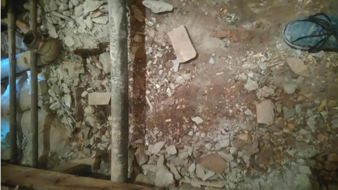
KUVA 5. Lattia ”työvalun” purun jälkeen
