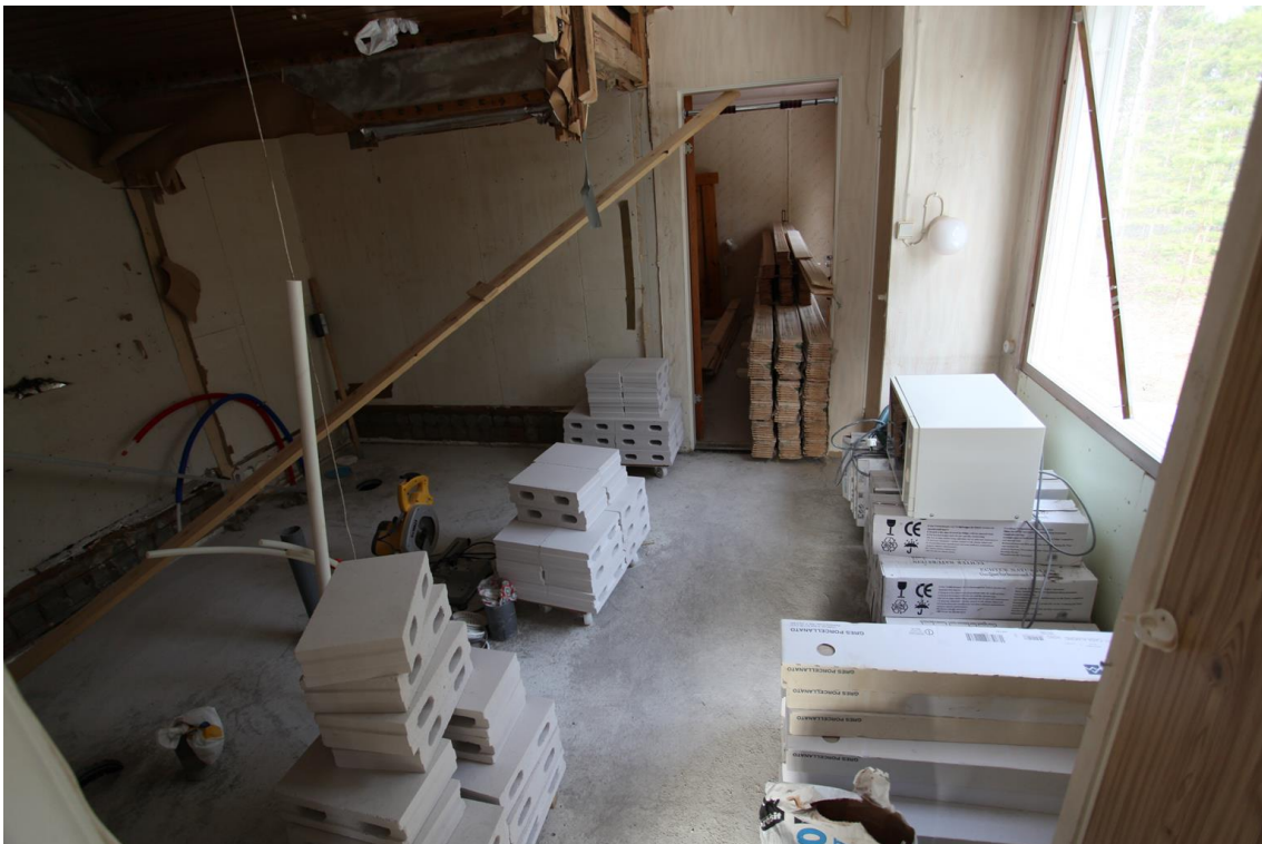
KUVA 13. Lattia valettu, seinämuurausten aloitusta
