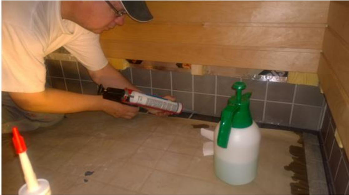
KUVA 17. Silikonisaumausta saunan lattian ja seinän liittymäkohtiin (Alanenpää 2015)
