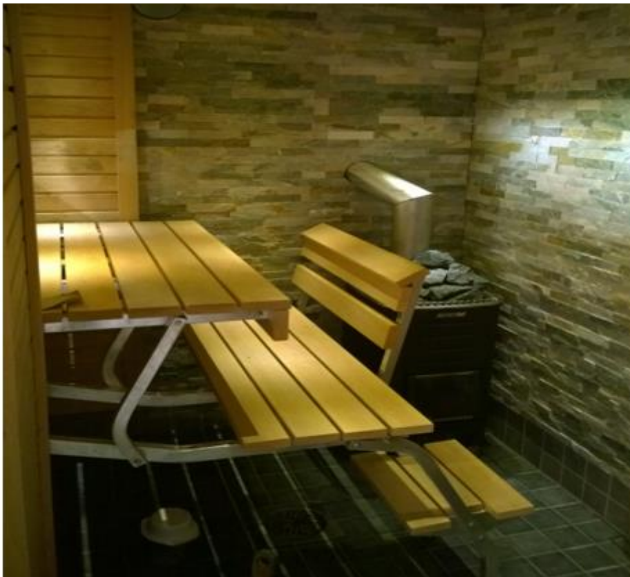
KUVA 22. Lauteet ja puukiuas asennettuina
