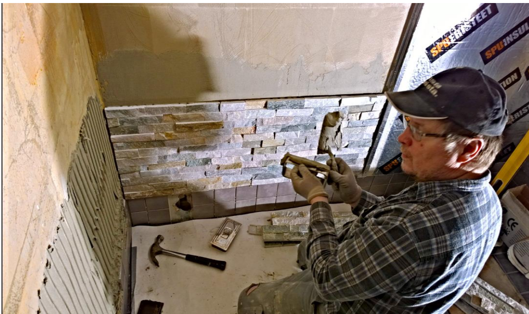
KUVA 18. Luonnonkiven asennusta (Alanenpää 2015)
