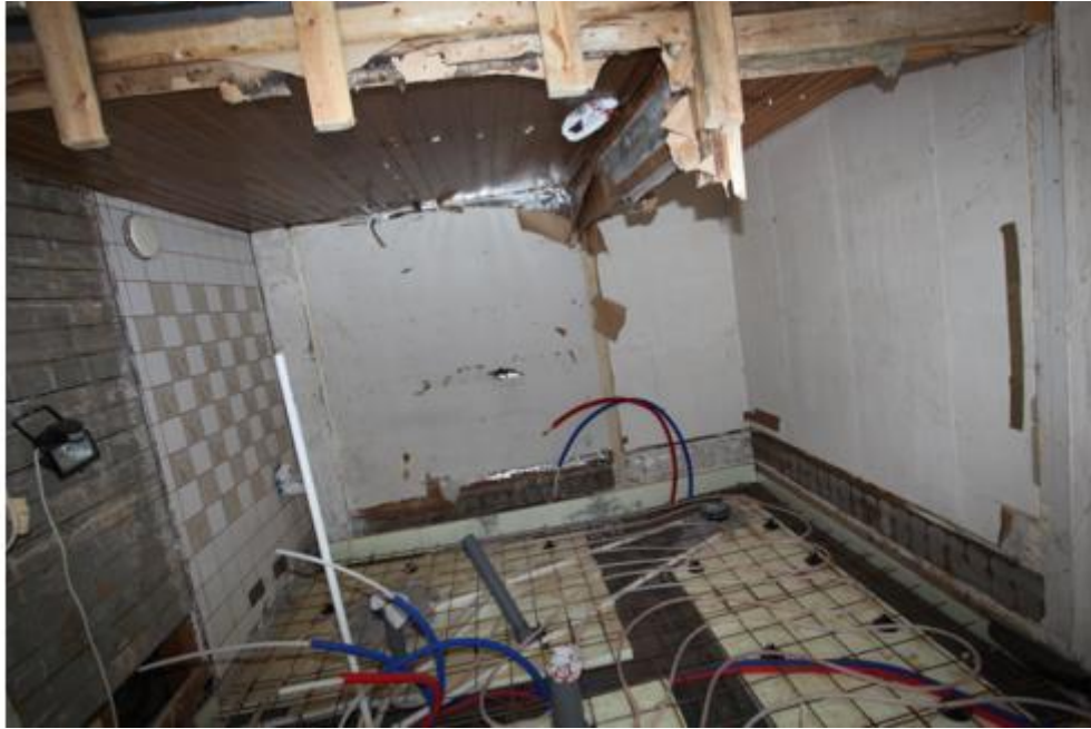
KUVA 6. Seinät purettuina ja lattia valmiina valua varten
