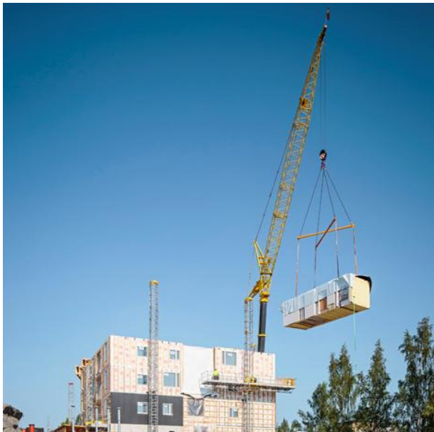
Kuva 2. CLT-tilaelementin asentamista Jyväskylässä Suomen korkeimman puukerrostalon Puukuokan työmaalla. [ http://www.clt.info/fi/projekte/detail/ .]
