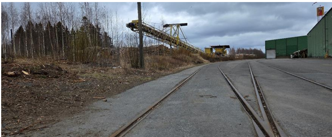
Kuva 22. Raiteen 185 viereinen varastoalue on reilusti korkeammalla kuin rata.
