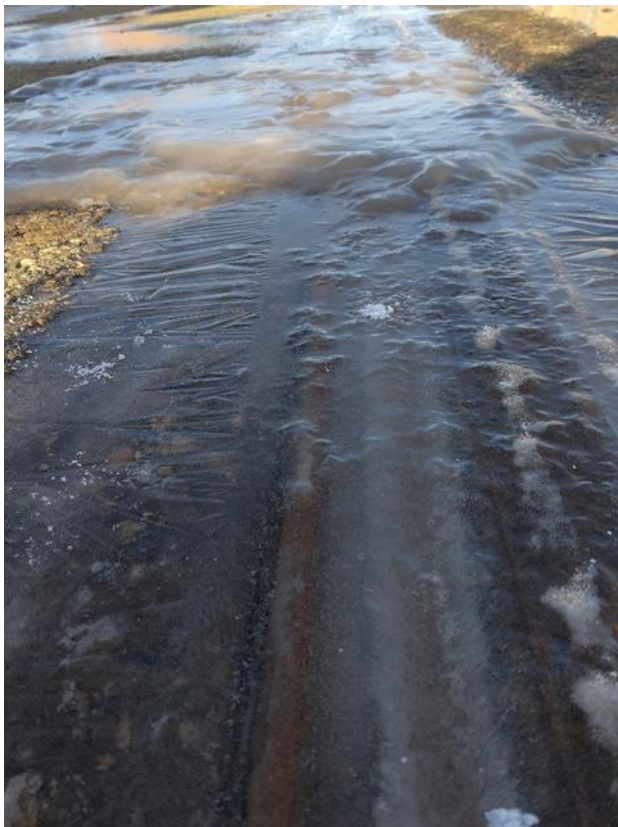
Kuva 20. Jäätyneet urakiskot
