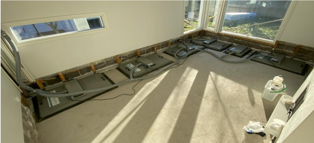
Kuva 16. Tasokuivain, maanvaraisen betonirakenteen lämpökuivaus tasokuivainten avulla.
