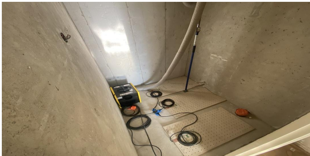
Kuva 17. Lämpömatto, betonirakenteisen välipohjan kuivaus lämpömattojen avulla.
