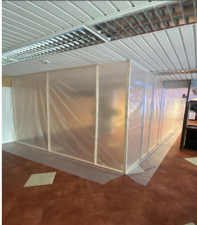
Kuva 12. Suljettu ja alipaineistettu purkutila.
