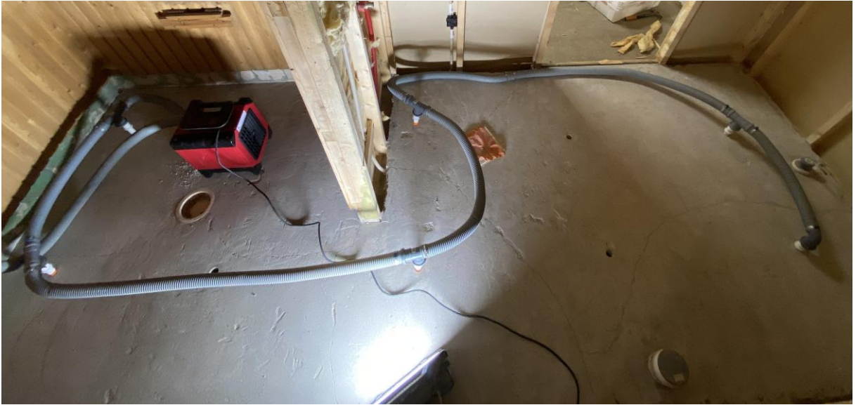
Kuva 15. Eristetilakuivain, tuplabetonilaattarakenteen eristetilaa kuivataan imukuivausmenetelmällä.
