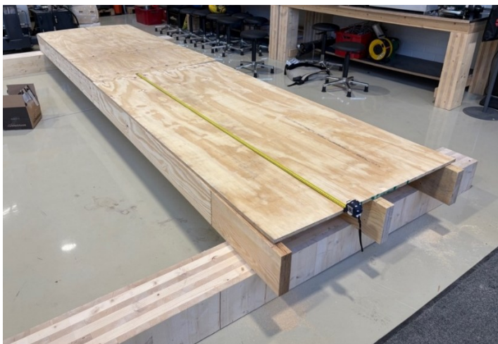
Kuva 9. Pohjalevyt palkkien päällä (Kuva: Jaakko Hokkanen).
