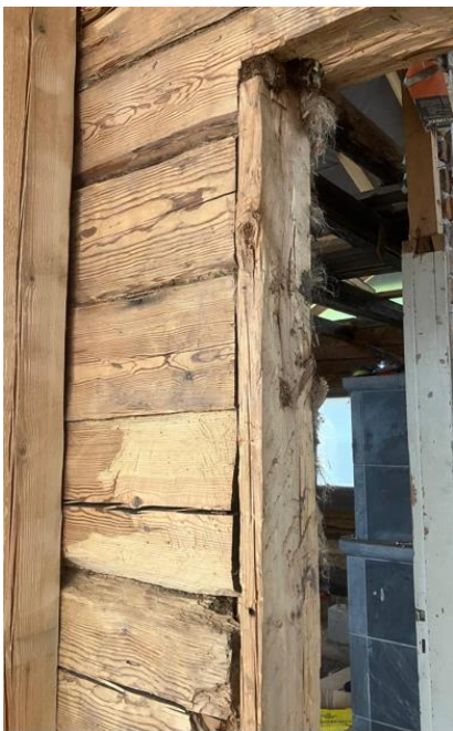
Kuva 21. Oven karapuu paikoillaan
