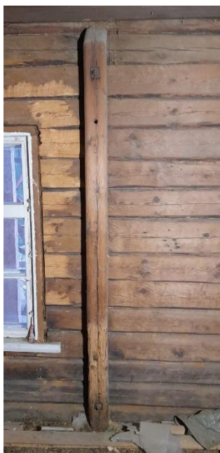
Kuva 23. Följäri ikkuna-aukkoa tukemassa
