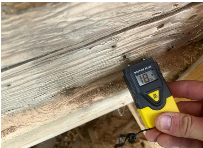
Kuva 44. Hirren kosteuden mittaus piikkimittarilla
