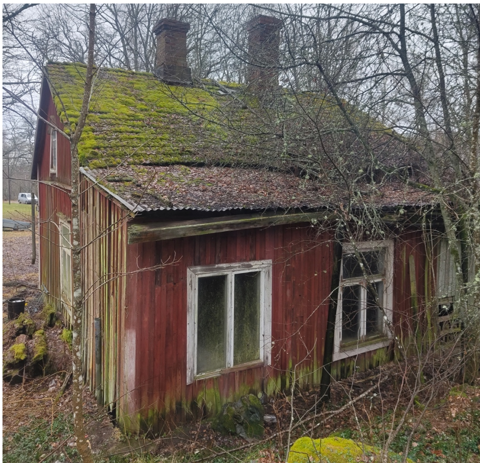
Kuva 16 Rakennuksen länsipuolelle tehty laajennus
