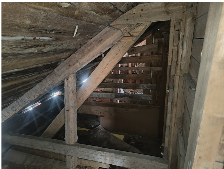
Kuva 17 Kuva rakennuksen kattotuolista
