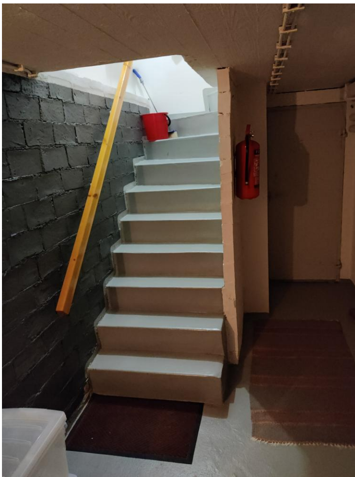
Kuva 8: Maalattu betonilattia sekä portaat.
