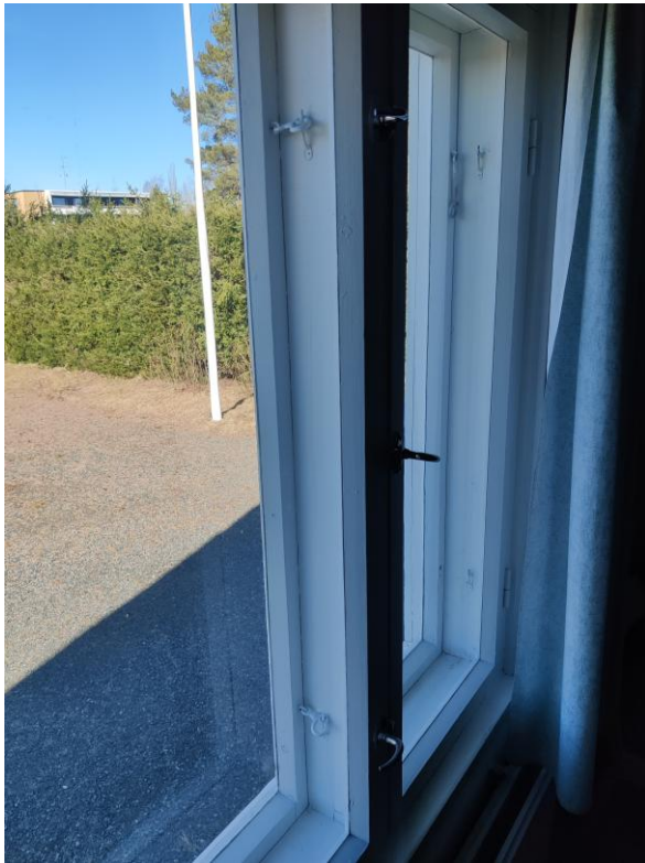
Kuva 5: Alkuperäinen ikkuna makuuhuoneesta.
