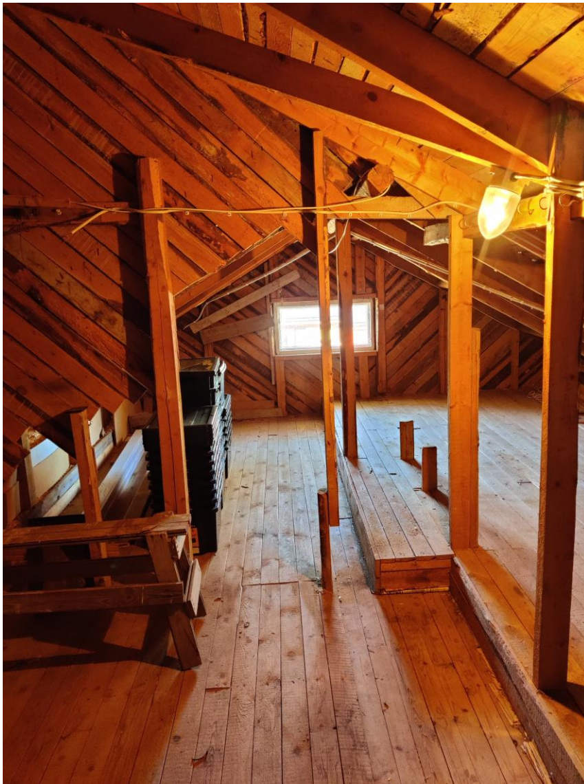
Kuva 7: Yläpohjatila, kattotuolia sekä ruodelaudoitusta.
