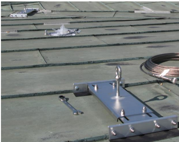
Kuva 9. LUX-top-valjaiden kiinnityspiste kolmelle henkilölle [28]
