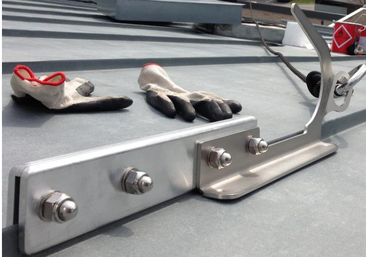
Kuva 8. LUX-top Turva Ykkönen -valjaiden kiinnityspiste [28].
