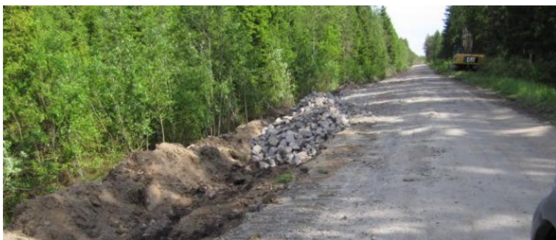
KUVA 21. Tien toispuoleinen levennystyo (Kuva: Ilvesluoto, 2014b).
