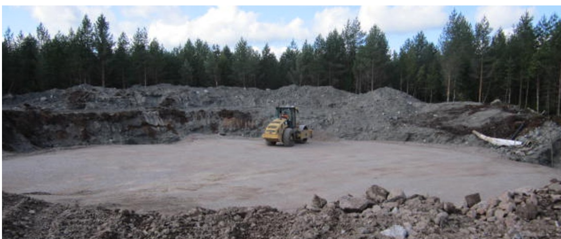
KUVA 31. Perustuksen alapuolisen murskekerroksen tiivistys (Kuva: Ilvesluoto, 2014d).
