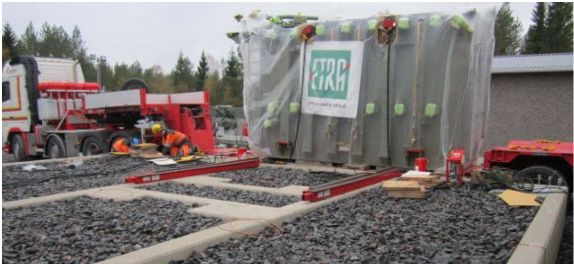
KUVA 11. Muuntajaa siirretään perustuksen päälle (Kuva: Ilvesluoto, 2014a).
