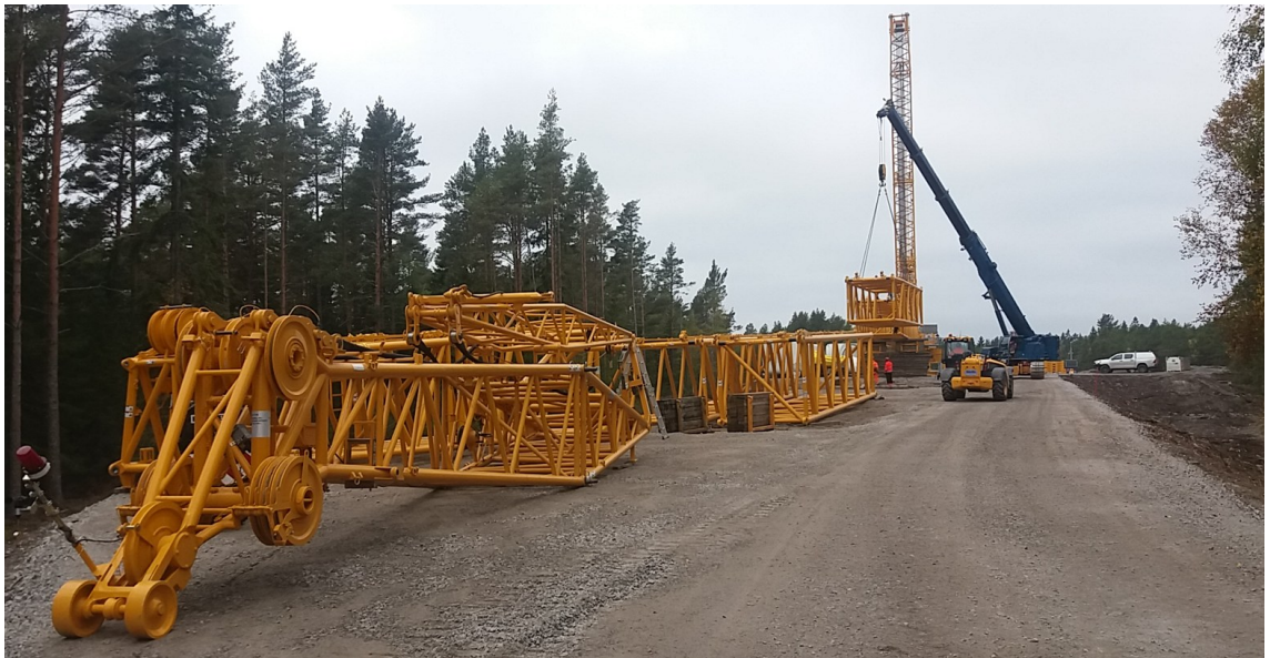
KUVA 30. Päänosturin puomin osia asennetaan apunosturin avulla (Kuva: Ilvesluoto, 2017h).
