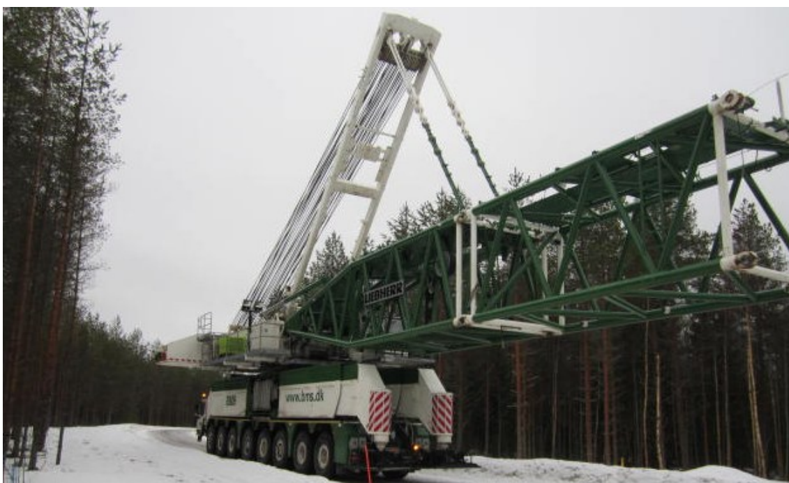
KUVA 19. Päänosturi siirtymässä seuraavalle voimalapaikalle (Kuva: Ilvesluoto, 2015b).
