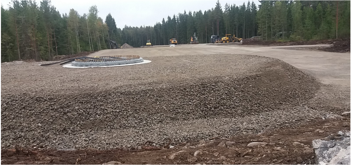
KUVA 32. Voimalan perustus ja nostokenttä (Kuva: Ilvesluoto, 2017i).
