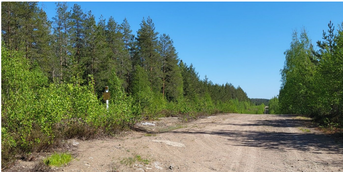
KUVA 38. Kaasuputket kulkevat kuvan tilanteessa tien molemmin puolin maan alla (Kuva: Ilvesluoto, 2024e).
