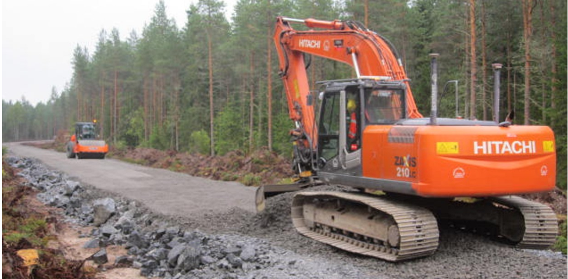
KUVA 24. Tietä rakennetaan hyvälle pohjamaalle (Kuva: Ilvesluoto, 2014c).
