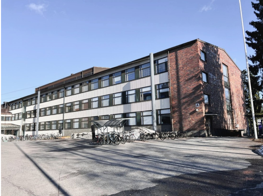
Kuva 3. A-rakennuksen lännen puoleinen julkisivu (Kuva: Anni Rantasuo).
