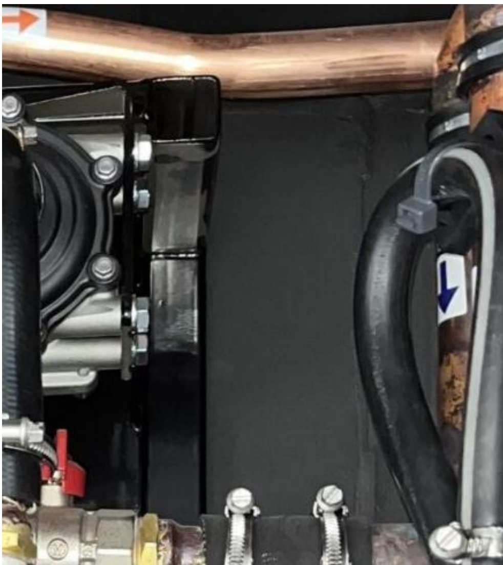
KUVA 6. Lämmitystilan seinä ilman johtojen läpivientä (Kuva: Ville Pääkkönen).
