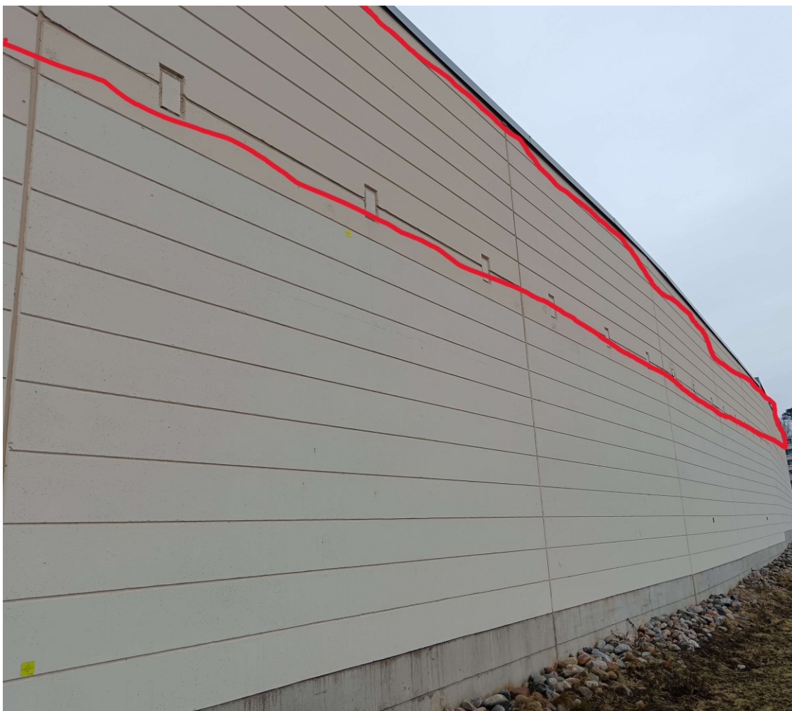
KUVA 11. Parkkikatoksen etelänpuoleinen seinä. Punaisella viivattu paneelien asennuspaikka, yli kahden metrin korkeudessa.
