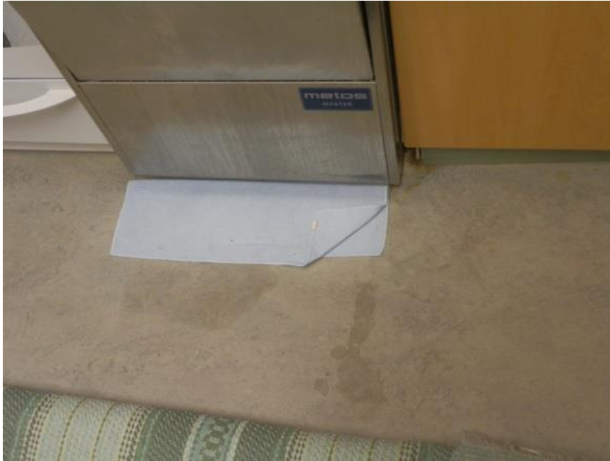
Kuva 15 Astianpesukoneen vuodosta aiheutuneita jälkiä matossa (Martikainen 2014-12-22.)
