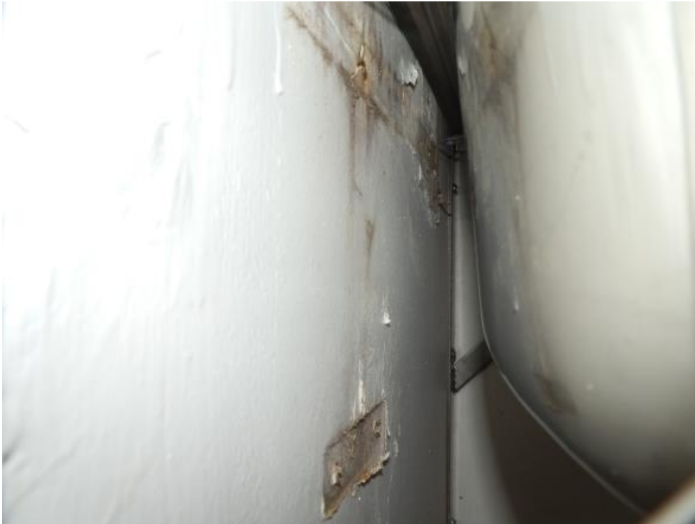
Kuva 16 Seinäpinta altaan takana (Martikainen 2014-12-29.)
