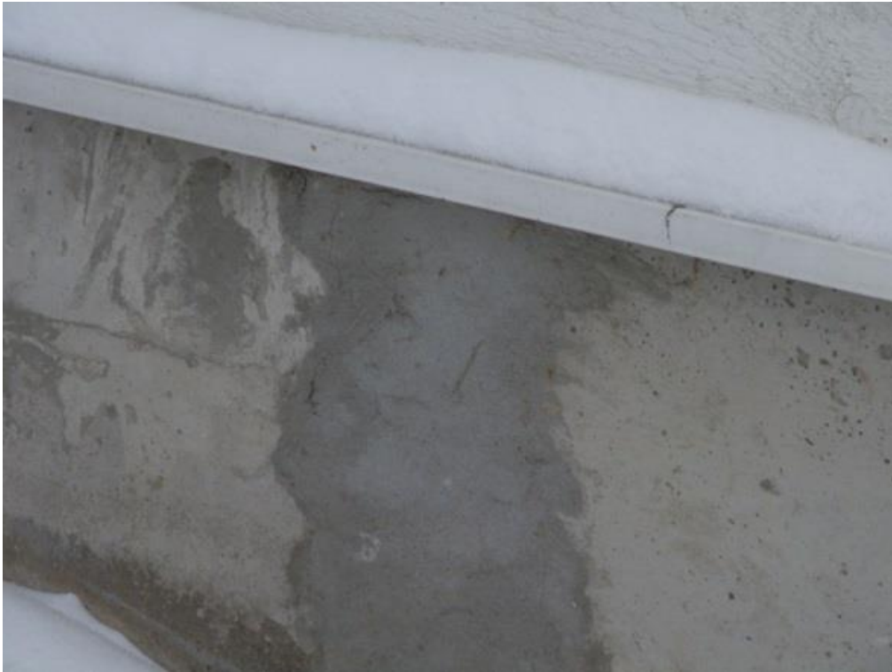
Kuva 4 Paikkauksia sokkelissa (Martikainen 2014-12-29.)
