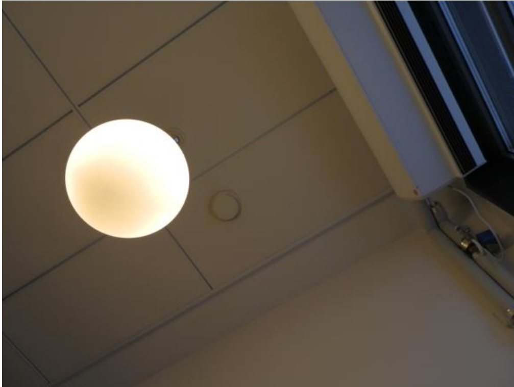
Kuva 11 Laajennusosa porrashuoneen katto (Martikainen 2014-12-22.)
