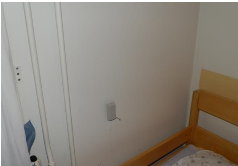
Kuva 18 Poistettu anturi (Martikainen 2014-12-29.)
