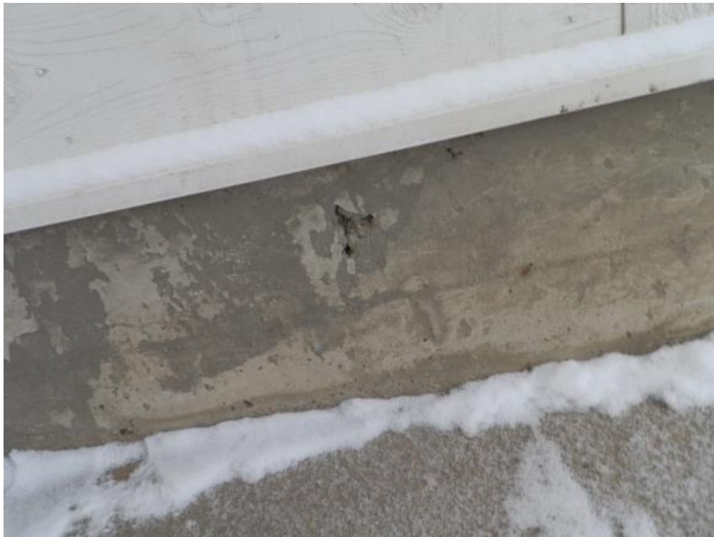
Kuva 3 Raudoitukset näkyvissä sokkelissa (Martikainen 2014-12-29.)
