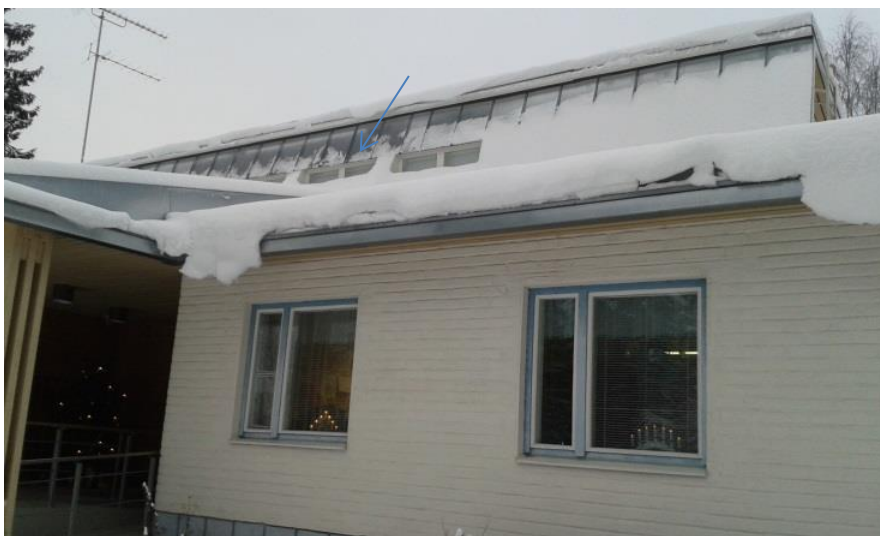
Kuva 13 Vesikatetta ja hätäpoistumistienä toimiva ikkuna (Martikainen 2014-12-22.)
