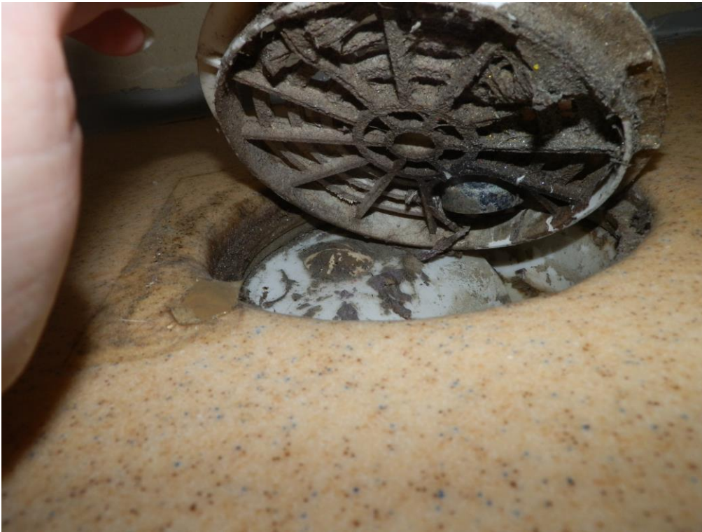
Kuva 20 Työhuoneen lattiakaivo (Martikainen 2014-12-29.)
