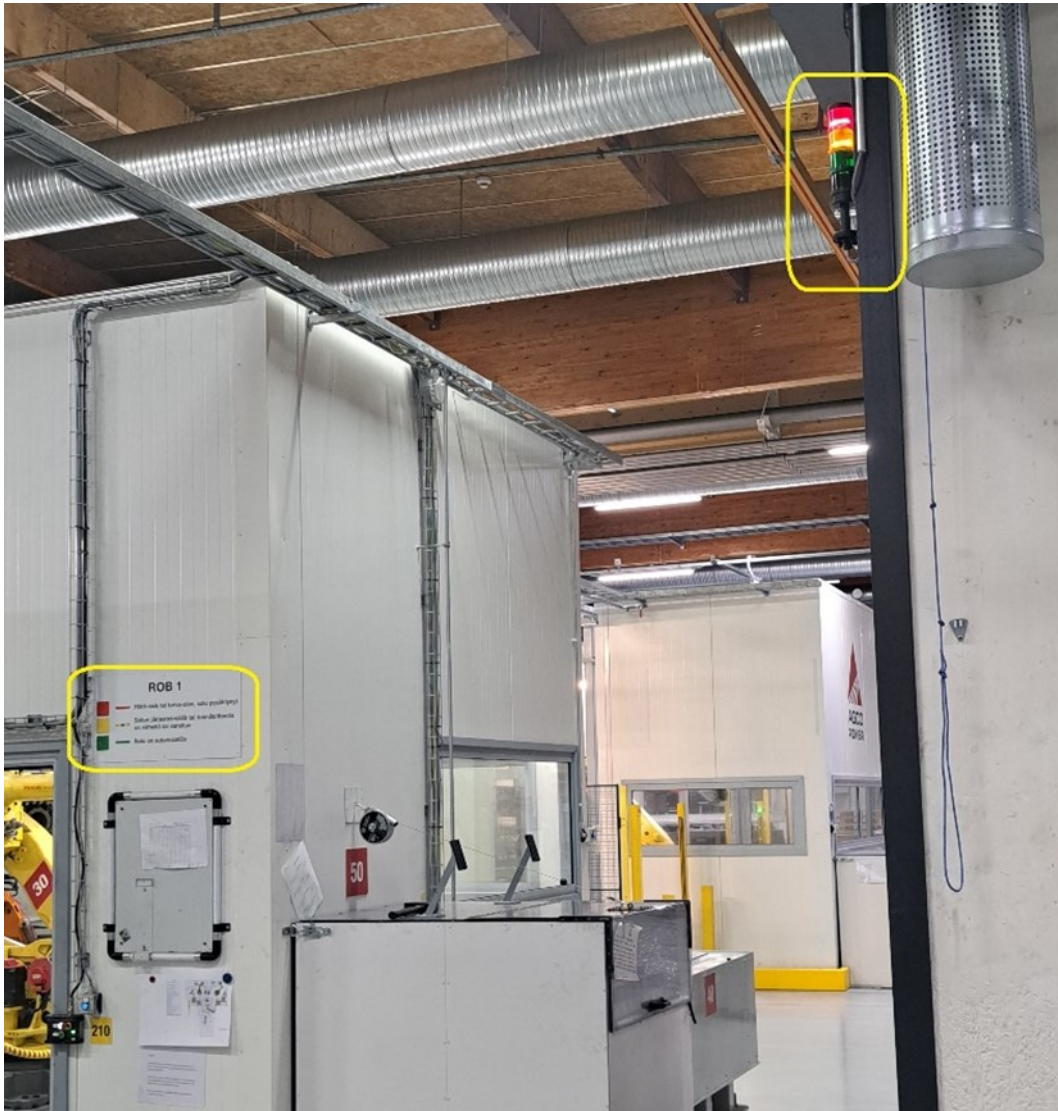
Kuva 26. Pylväsmajakka ja symbolitaulu sijaitsevat erillä toisistaan
