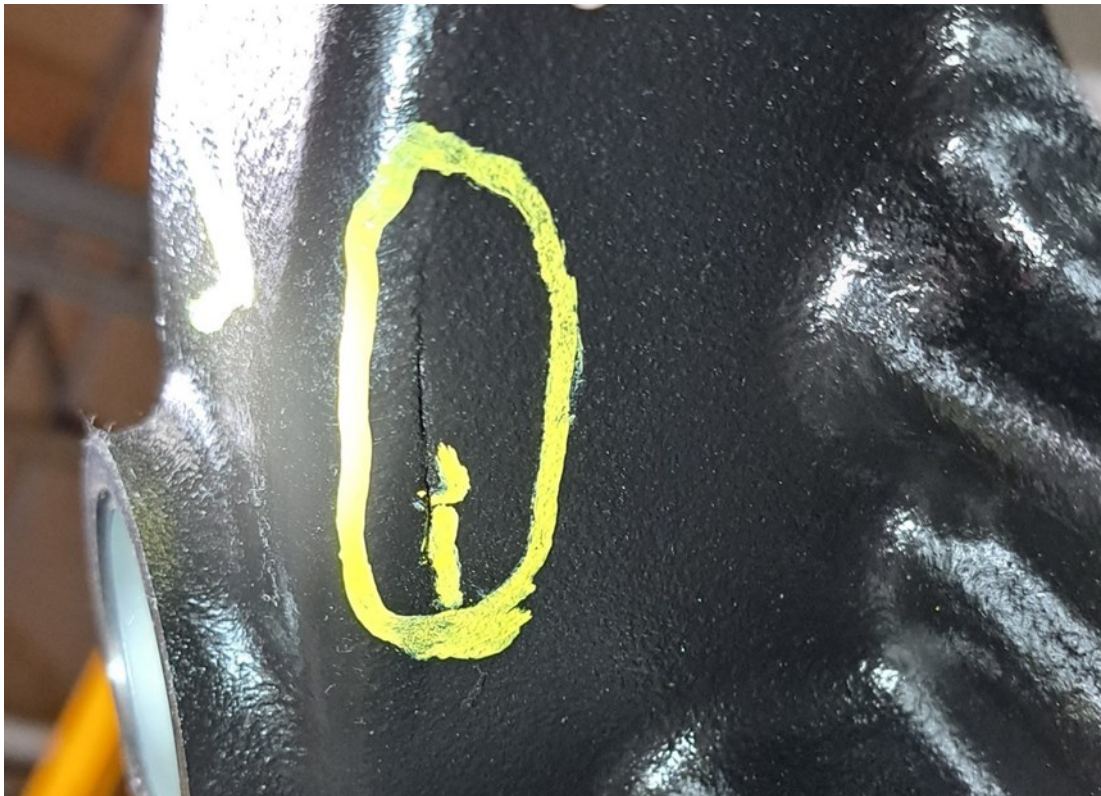
Kuva 9. C75 -sylinteriryhmän valussa havaittu halkeama, josta aiheutui vuoto
