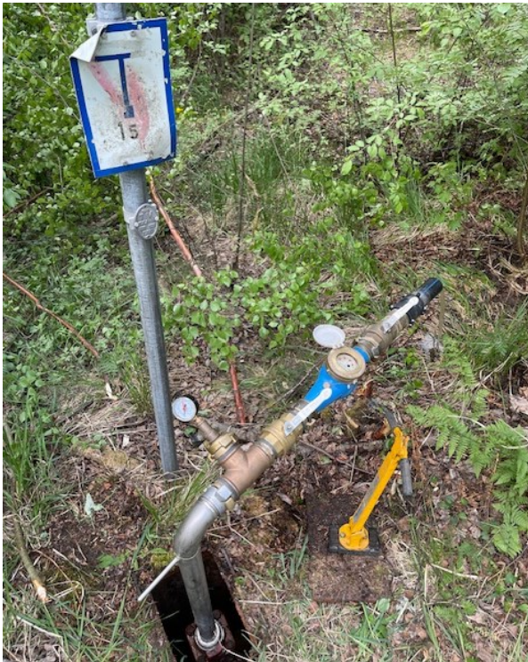
Kuva 2 Maanalaisen palopostin mittauslaitteisto.
