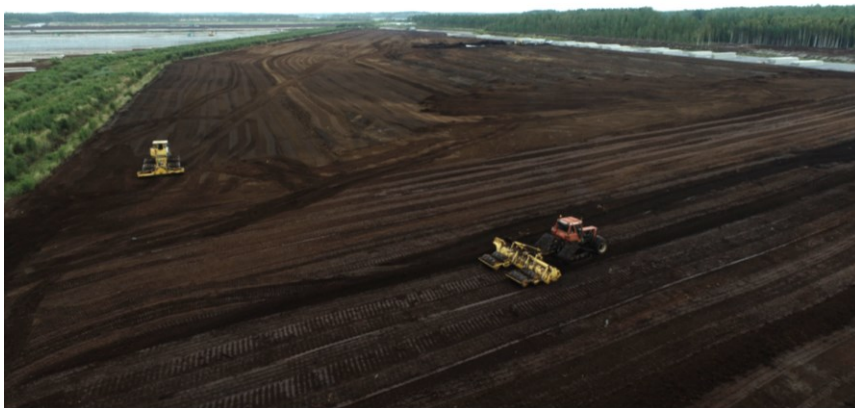
Kuva 38. Hankealueen tasaus ennen perustuksia (EPV Aurinkovoima Oy, 2024).
