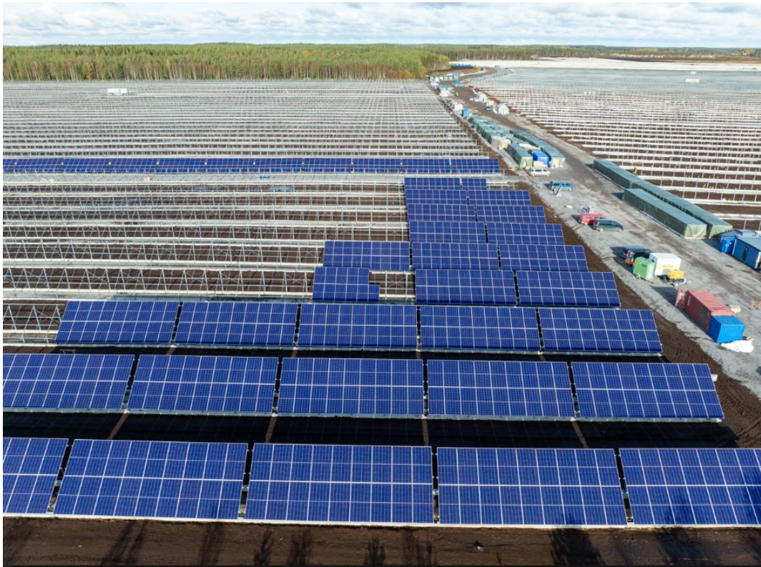
Kuva 41. Muuntajalohkojen 1 ja 2 paneelien asennus (EPV, Aurinkovoima Oy, 2024).
