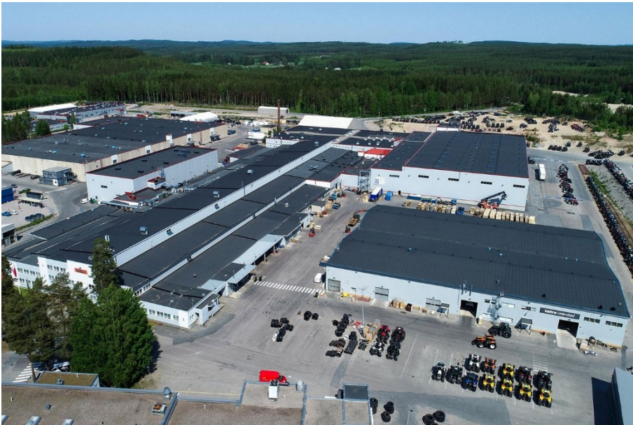
KUVA 1. Valtran Suolahden tehdaskompleksi
