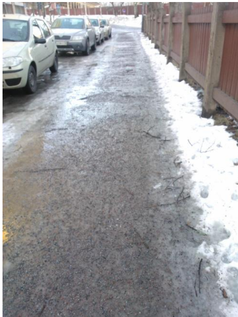
Kuva 17. Sulamisvesi kastelee ja liukastuttaa jalkakäytävän.
